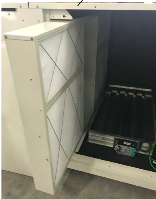
A la izquierda, Prefiltro G4 limpiable; A la derecha, lugar de filtros indicados por etiqueta.
