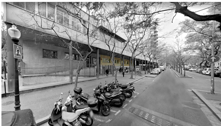
Vista del CAP des de l'avinguda de les Drassanes. Marcat a color la zona d'actuació
