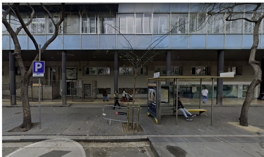
Entrada des de l'espai públic a la planta baixa del CAP
