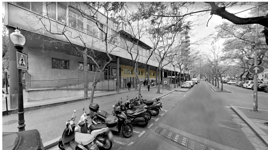
Vista del CAP des de l'avinguda de les Drassanes. Marcat a color la zona d'actuació
