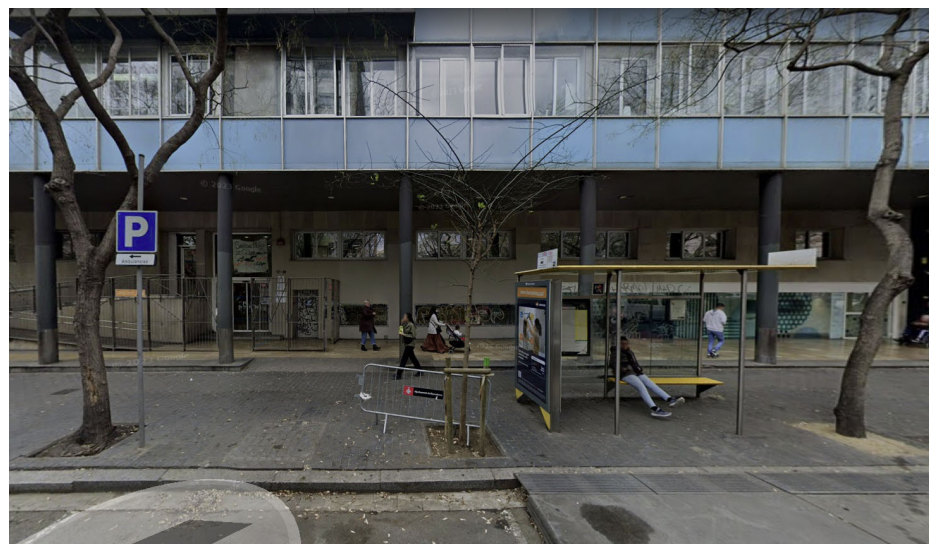
Entrada des de l'espai públic a la planta baixa del CAP
