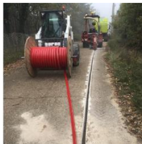
Exemple de treballs d'estesa manual de microductes i exemple d'obertura i estesa simultànies
