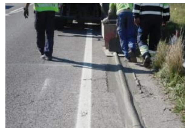
Procés de rebliment de la rasa amb morter i exemple dels treballs de pintat de la línia blava
