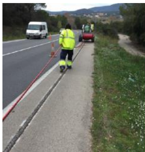
Exemple de treballs d'estesa manual de microductes i exemple d'obertura i estesa simultànies
