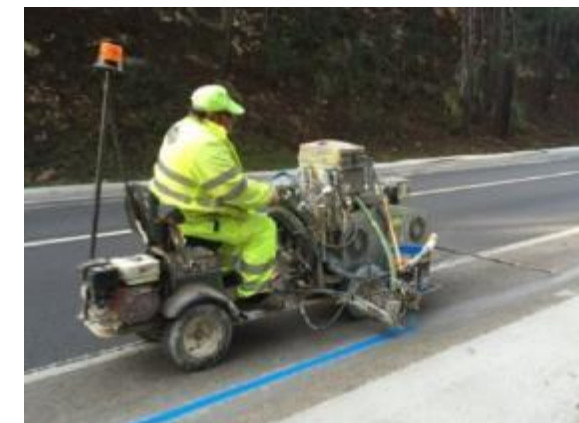
Procés de rebliment de la rasa amb morter i exemple dels treballs de pintat de la línia blava
