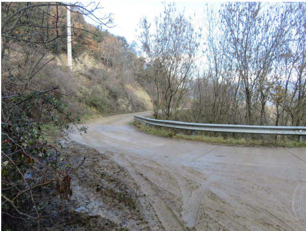
Estat actual del camí
