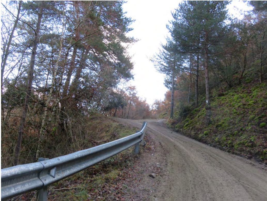
Estat actual del camí
