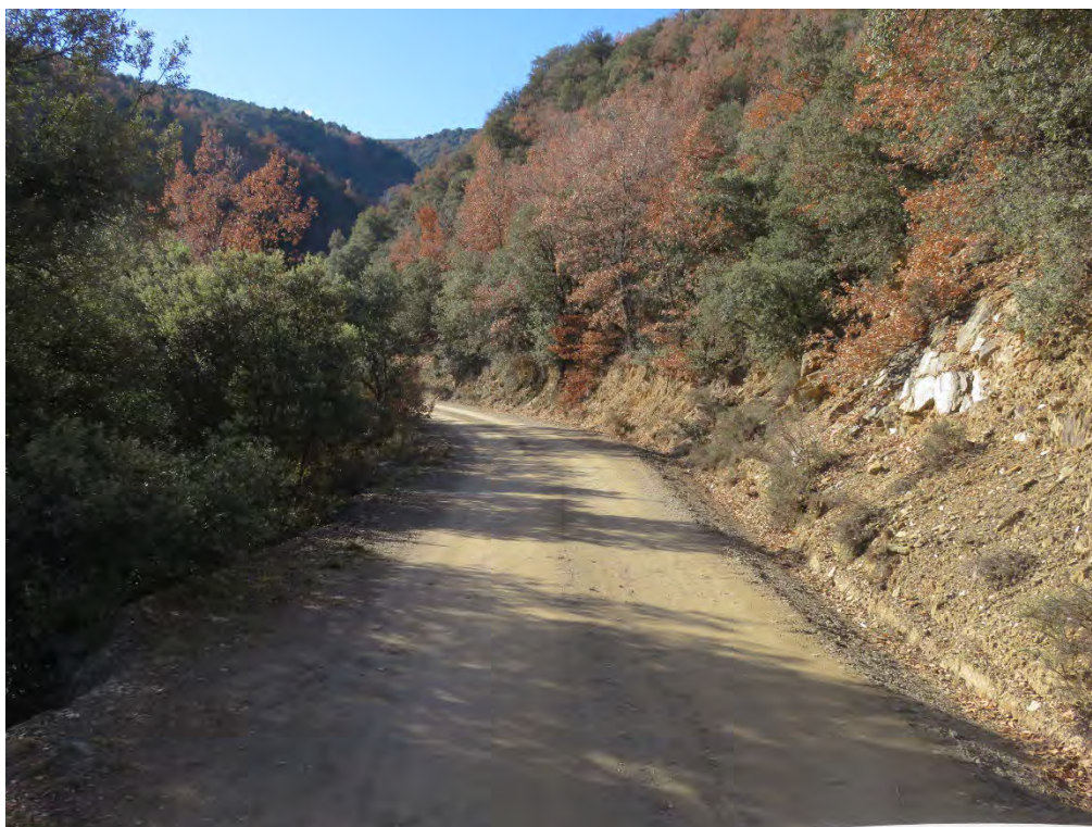
Estat actual del camí
