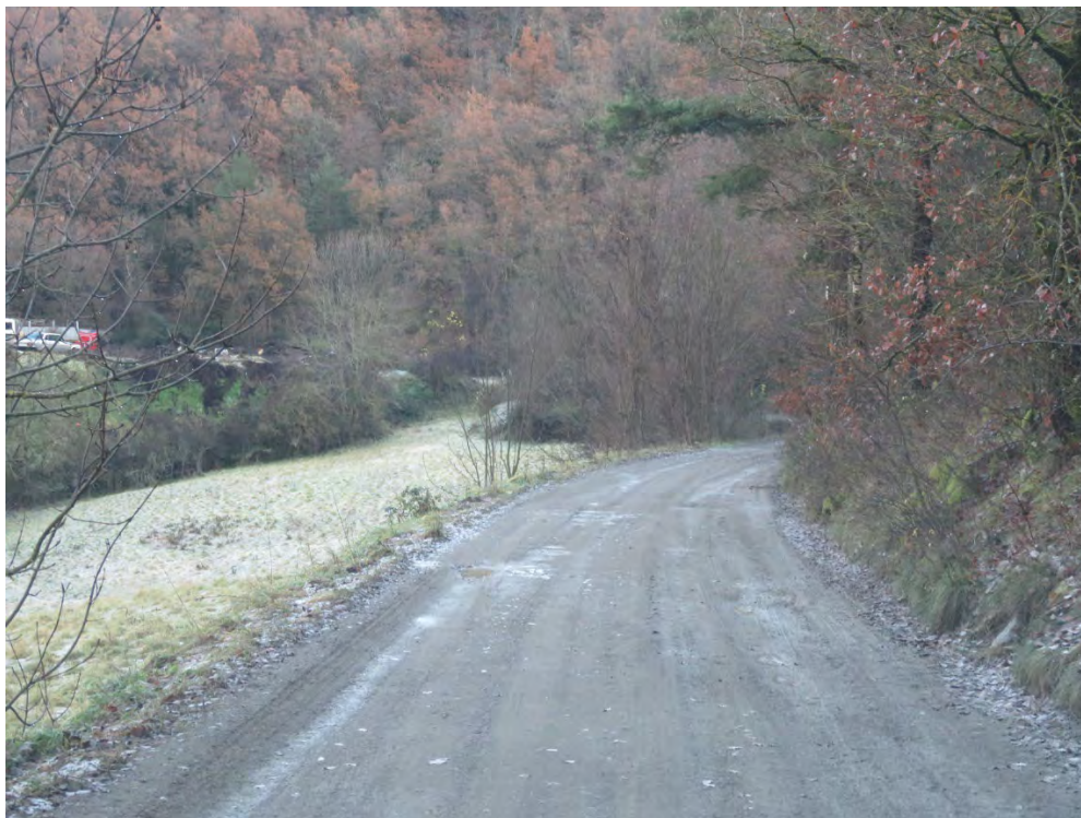
Estat actual del camí
