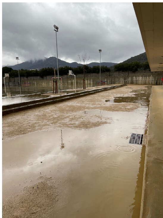
Exterior zona oest
