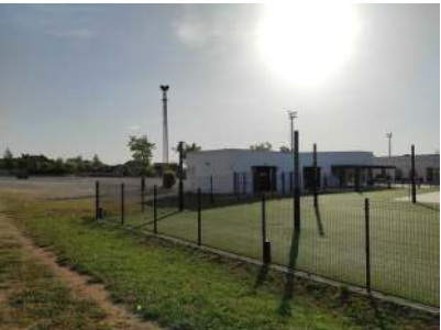
FAÇANA SUD I OEST
