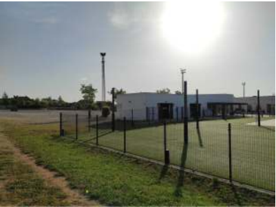
FAÇANA SUD I OEST
