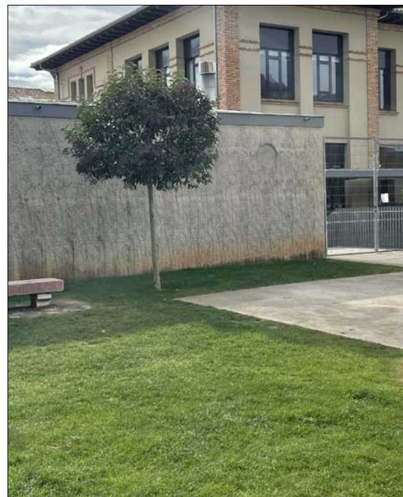
PUNT D'ENTRADA A SALA DE CALDERES
