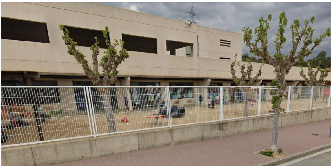
Estat actual pati infantil de l'escola la Vinya del Sastret
