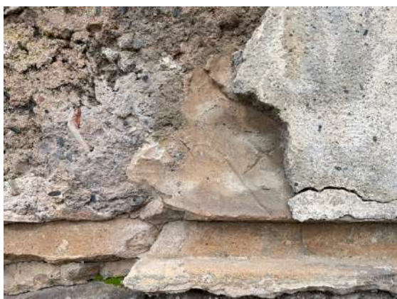
Fotografies detall on s'aprecia el sistema constructiu de l'arrebossat tipus 2, ambdós morters diferenciats
