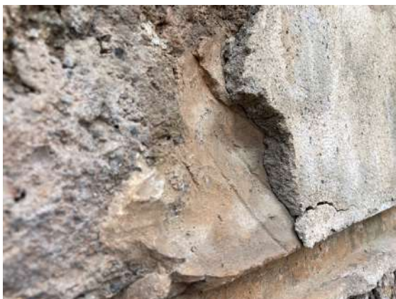
Fotografies detall on s'aprecia el morter M1 aplicat tant lliscat com de farciment a les cales 2 i 11
