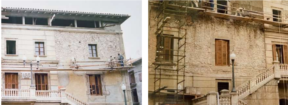
Fotografies de 1989 on s'aprecia la construcció del parament de la façana
