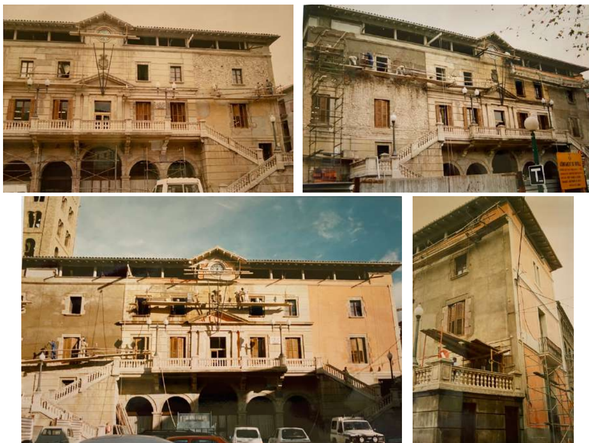
Fotografies del procés de rehabilitació de les façanes de 1989 (ACRI 29 )
