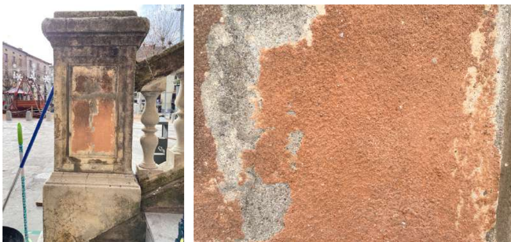
Fotografies on s'aprecia les restes del P2 al primer tram de l'escala (esq.) i restes de la capa monocroma (dret.)
