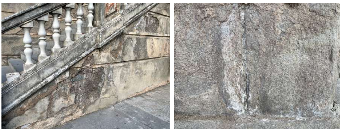
Fotografies detall del creixement de eflorescències salines
