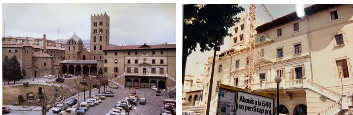
Fotografies de la façana abans de la rehabilitació de 1989 on s'aprecia la capa monocroma beix
