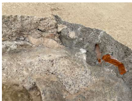
Fotografies detall on s'aprecia el morter M1 aplicat tant lliscat com de farciment a les cales 2 i 11
