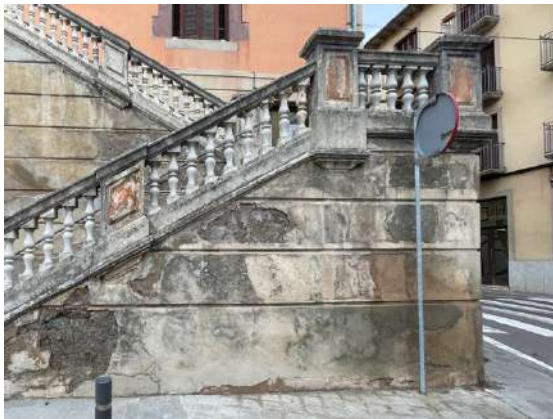
Fotografies on s'aprecia les restes del M3 al primer tram de l'escala (esq.) i petits restes amb un estat de conservació deficient (dret.)
