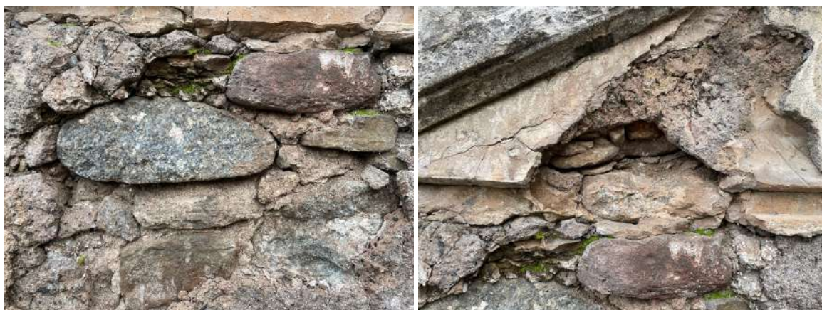
Fotografies detall de la descohesió i pèrdua de morter de junta
