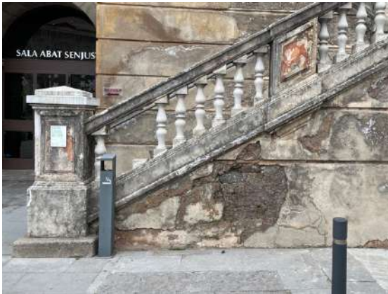
Fotografies on s'aprecia les restes del M3 al primer tram de l'escala (esq.) i petits restes amb un estat de conservació deficient (dret.)
