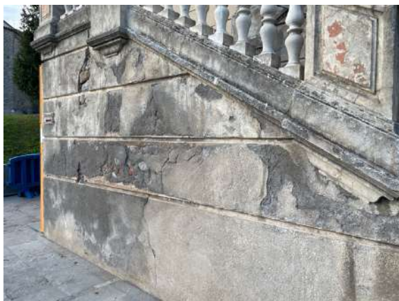
Fotografies detall de la disgregació de l'arrebossat de l'escala
