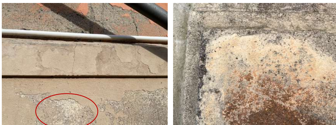
Fotografia on s'aprecia les restes del P3 al de l'escala (esq.) i restes de la capa monocroma (dret.)
