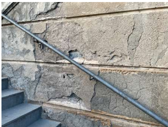
Fotografies detall de la disgregació de l'arrebossat de l'escala
