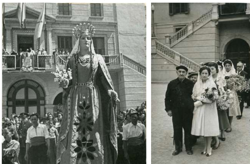
Fotografia de 1945 21 i de 1958 22 on s'aprecia la substitució de la balustrada
