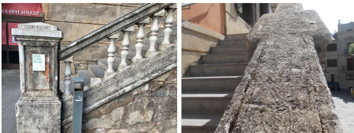
Fotografies detall del enfosquiment de les superfícies (esq.) i l'arrodoniment de les formes per pèrdua de material (dret.)
