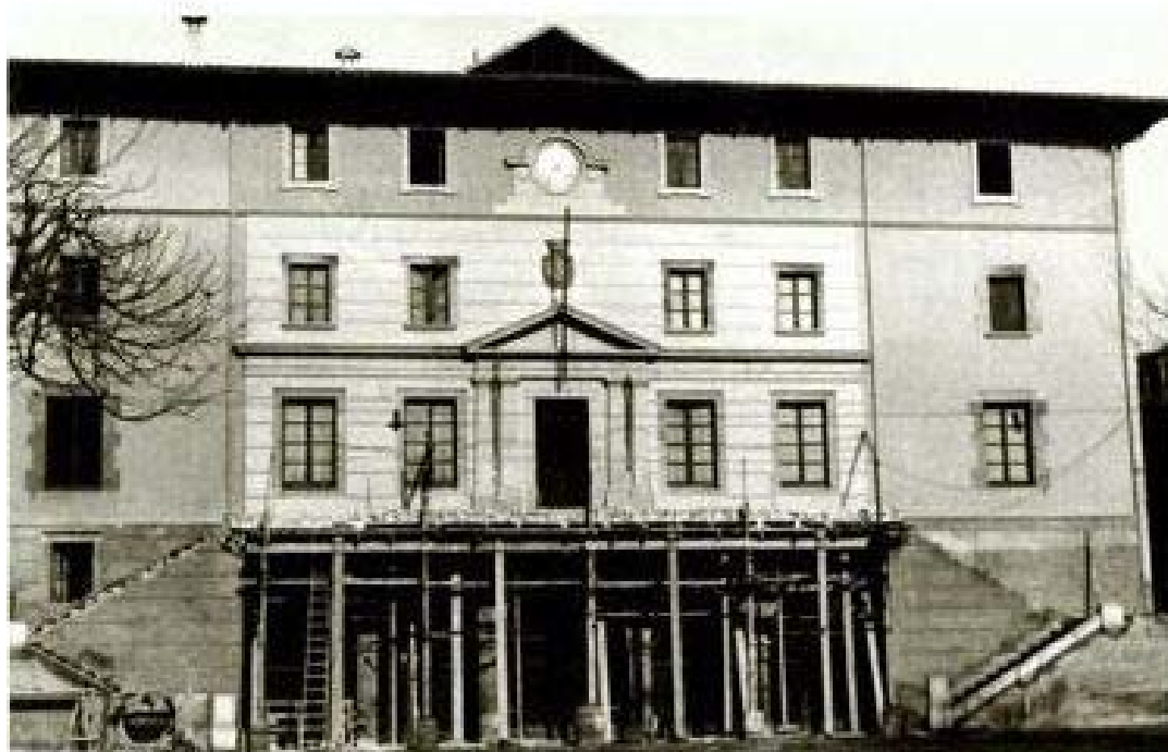
Actuació de remodelació de la façana de l'Ajuntament (1954-1955) consistent en la supressió de la torre de l'observatori meteorològic i renovació de les escales i balconades i coberta de l'edifici.
