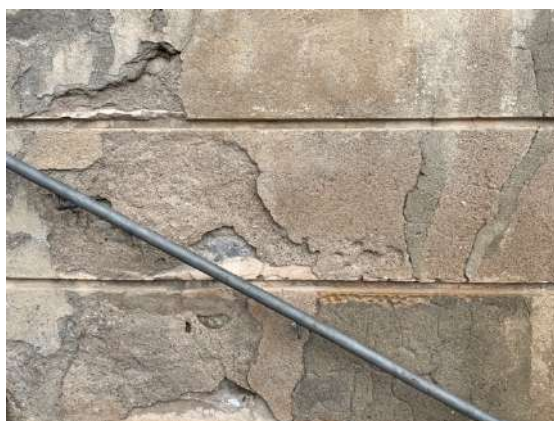
Fotografies detall on s'aprecia el sistema constructiu de l'arrebossat tipus 2, ambdós morters diferenciats
