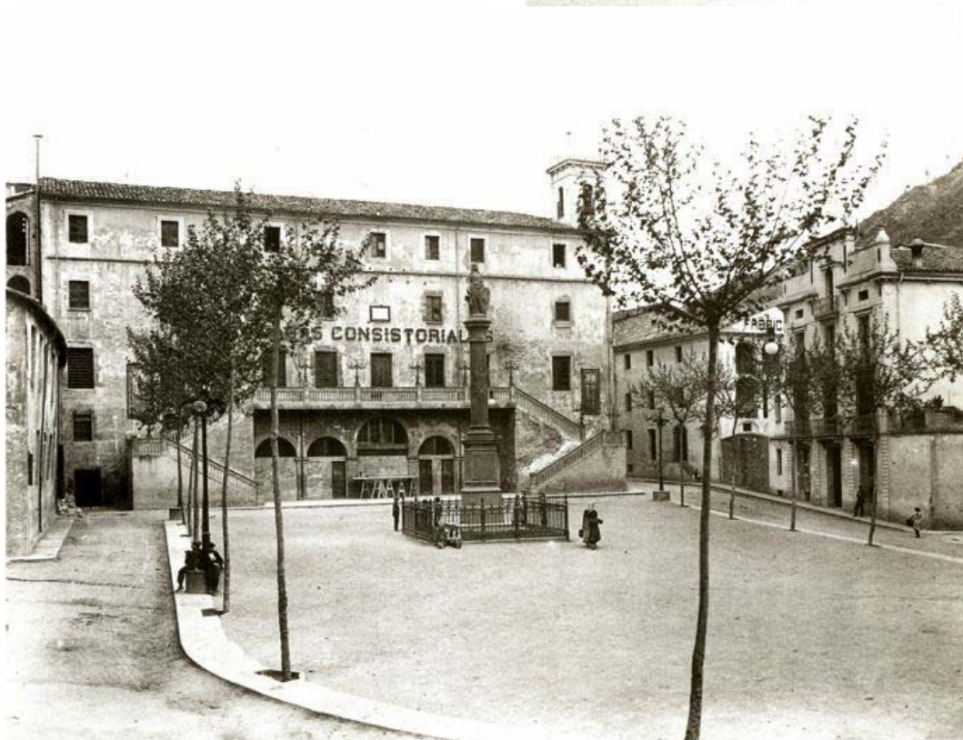
Façana de l'Ajuntament amb les actuacions dutes a terme a mitjans del segle XIX posteriorment a la desamortització dels béns monàstics. Imatges entre els anys 1909 i 1911.
