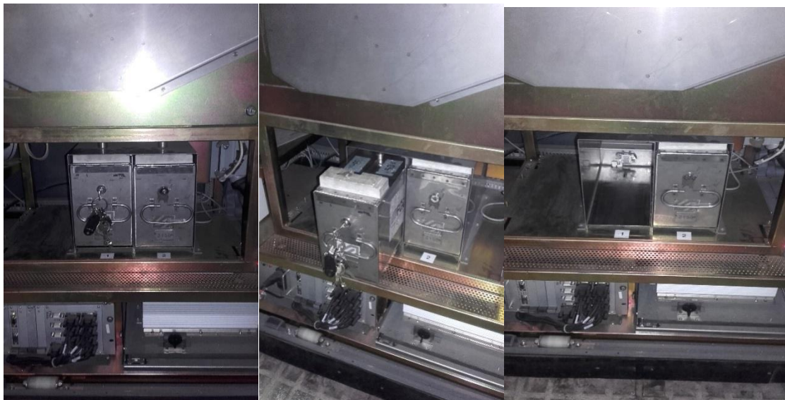
Figura 61. Introducció de la clau per a extreure la caixa
