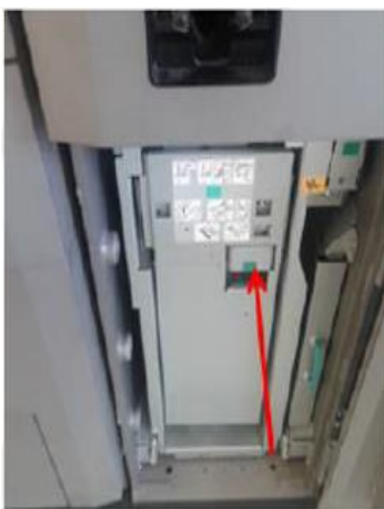
Figura 82. Tancament de la caixa amb empènyer
