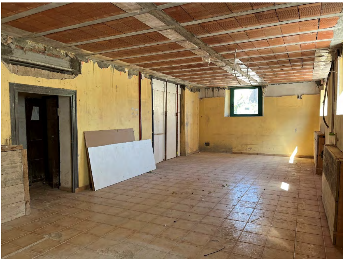
Imatge interior crugia esquerra, zona OAC
