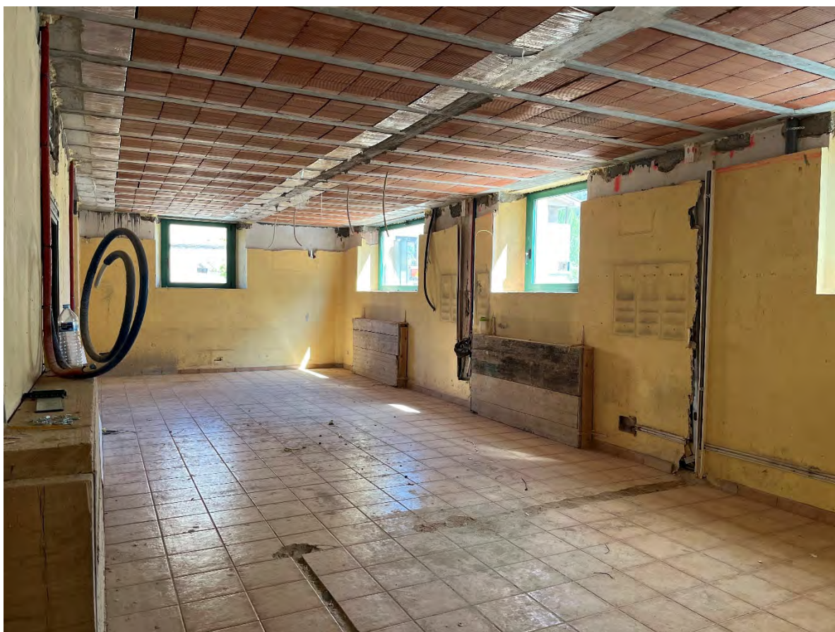
Imatge interior crugia esquerra, zona OAC
