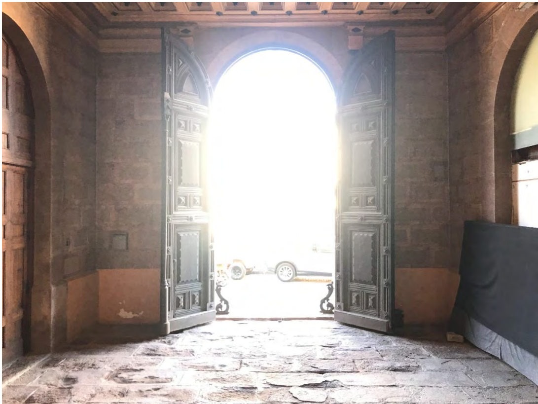
Imatge interior des de l'accés cap a fora
