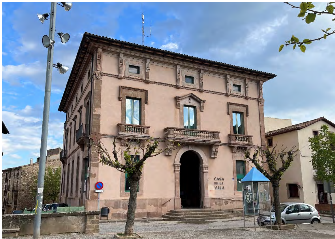
Imatge exterior façana principal amb l'accés, des de la plaça Sant Sebastià
