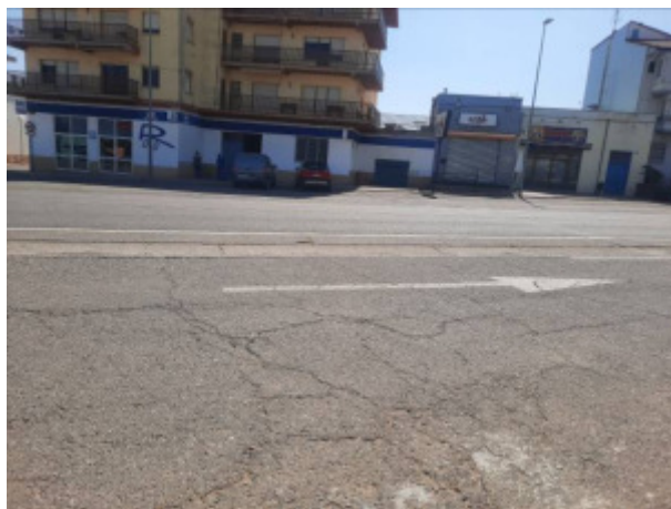
Vista des del C. Pilar d'Almenara - C. Masies
