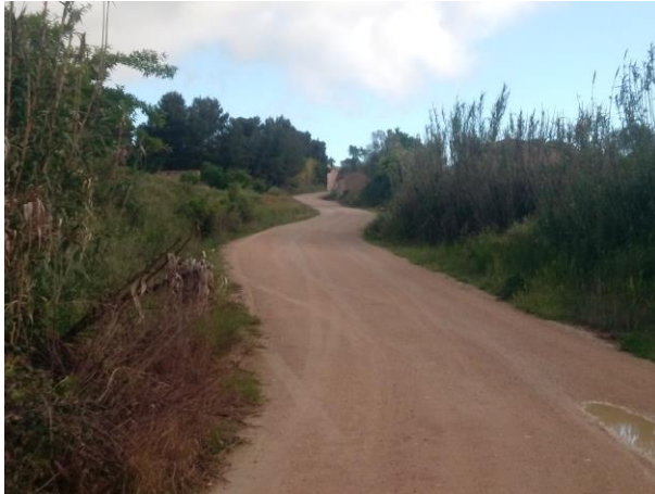
Imatge 22: Camí que creua el torrent del Pont del Patacó, a la dreta arriba el col·lector i es produeix l'abocament 3. Pel camí transcorreria la nova impulsió.
