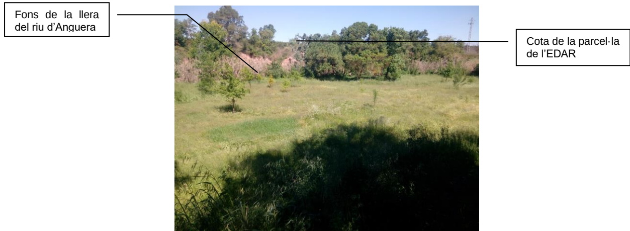
Imatge 13: Desnivell entre el marge dret i el marge esquerre de la llera a l'alçada de la parcel·la de l'EDAR. Imatge presa des del costat de la carretera T-242, al marge dret de la llera.
