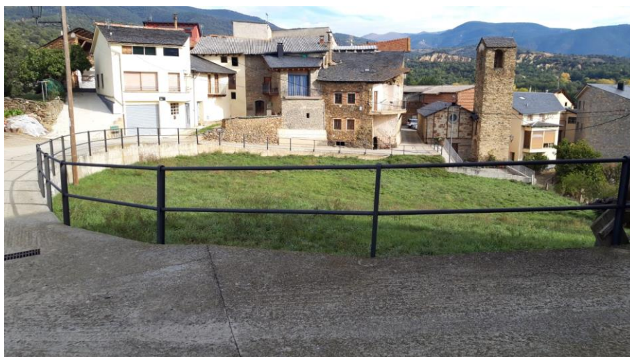
FOTO 5: Vista de barana existent - BELLESTAR
