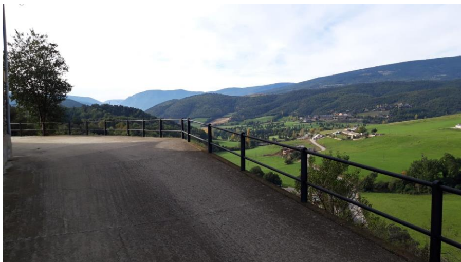
FOTO 4: Vista de barana existent - BELLESTAR
