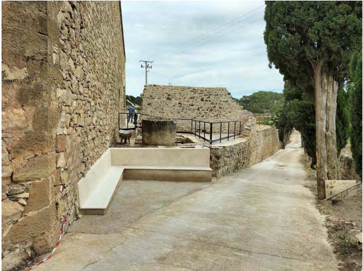
Vista laterals des del Camí de Sant Jaume del cos annex
