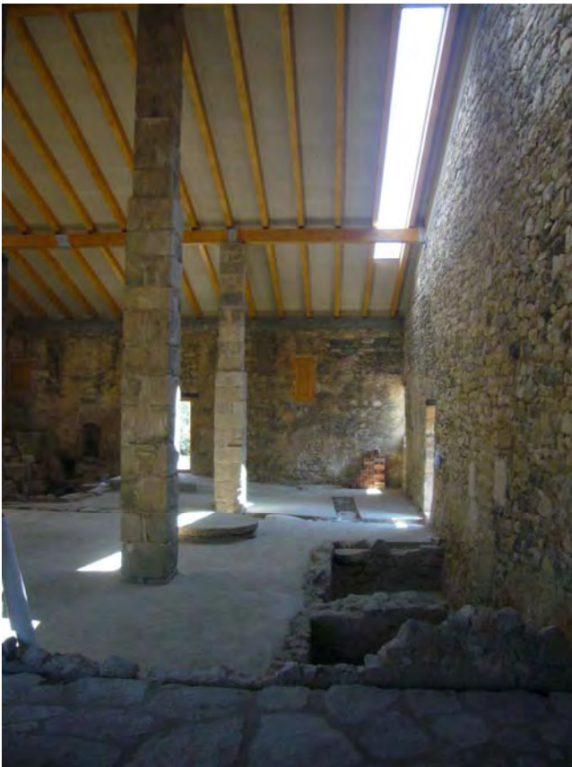
Dipòsits i canalitzacions
