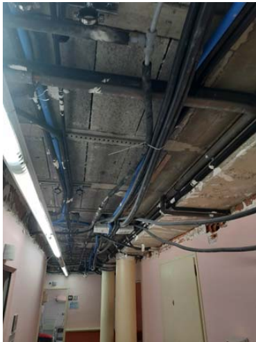
Detall 1 distribució aigua per sostre planta primera
