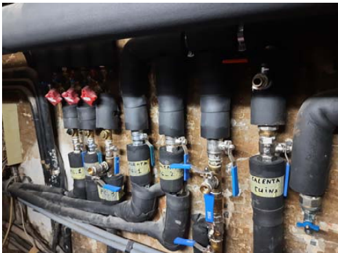
Detall col·lectors aigua calenta i recirculació
