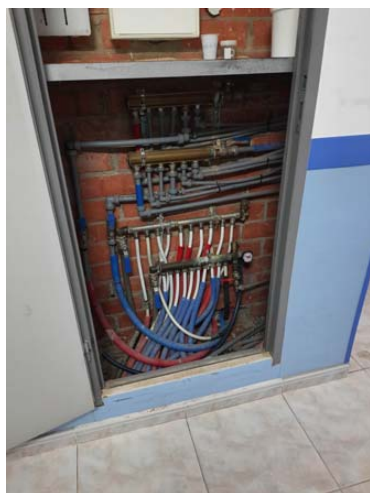
Detall 1 armari distribució planta tercera
