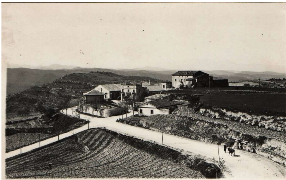
Fàbrica de Calders amb la primera fase de la segona nau ja construïda (1931). Arxiu Jorba
