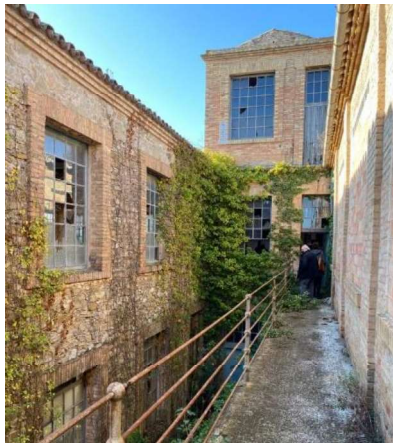
Imatges interiors des de planta primera. Coberta ensulsida.
