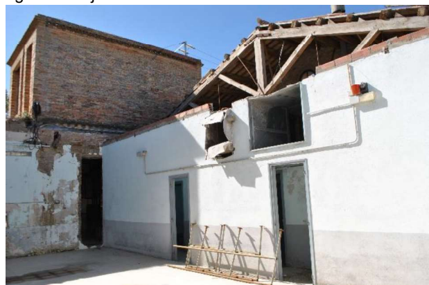
Imatges interiors des de planta primera. Coberta ensulsiada.
