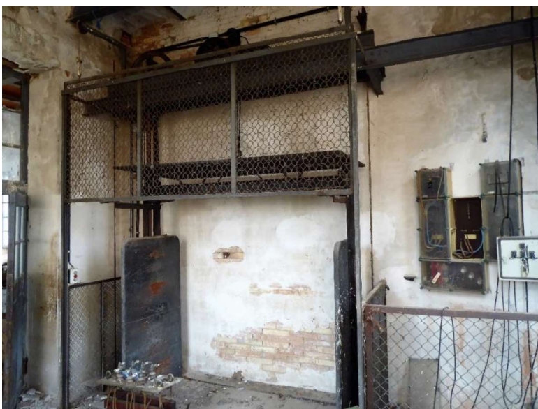
Instal·lació del muntacàrregues
