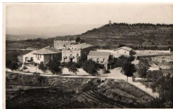
Any 1935. Les dues noves construccions al sector nord i la construcció de la segona planta del xalet Font: Arxiu Lluís G. Jorba Gomis
