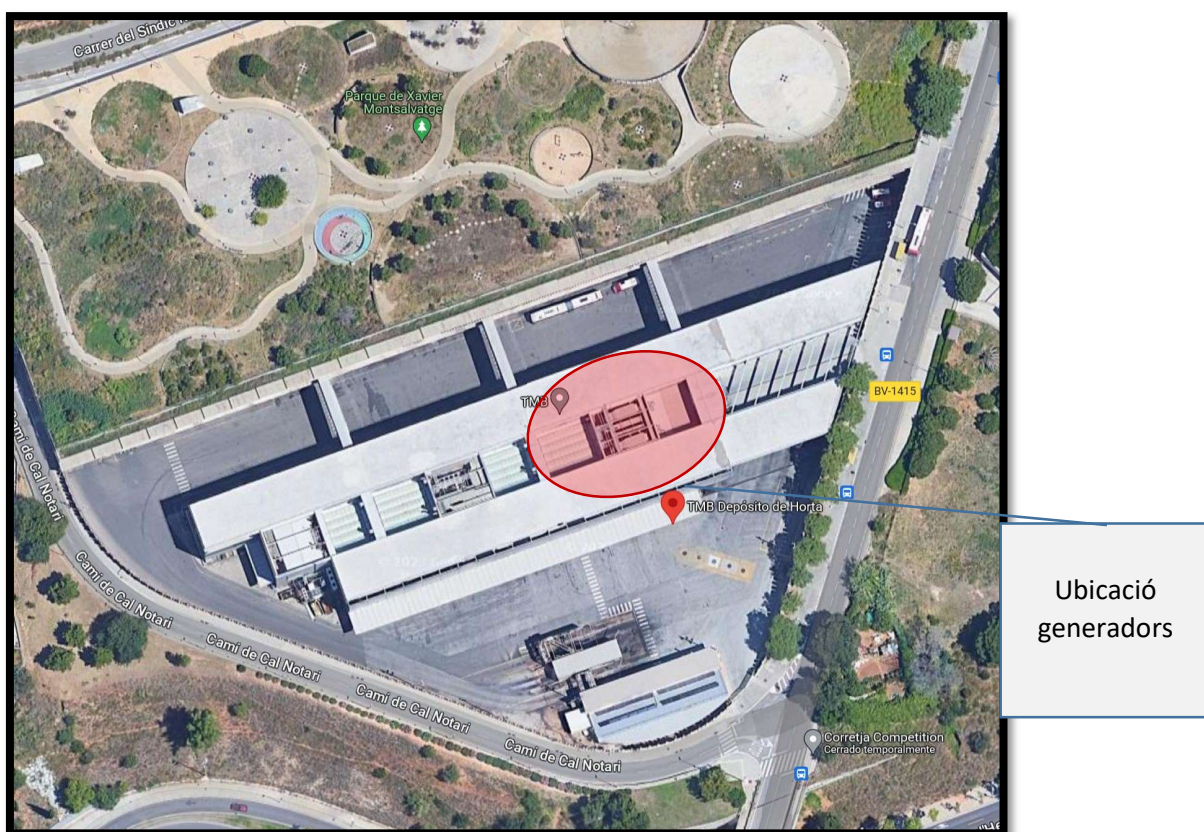
Imatge 1 – situació equips generadors
