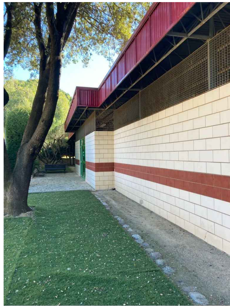
IMG. 1 - RETRANQUEIG D'ENTRADA
