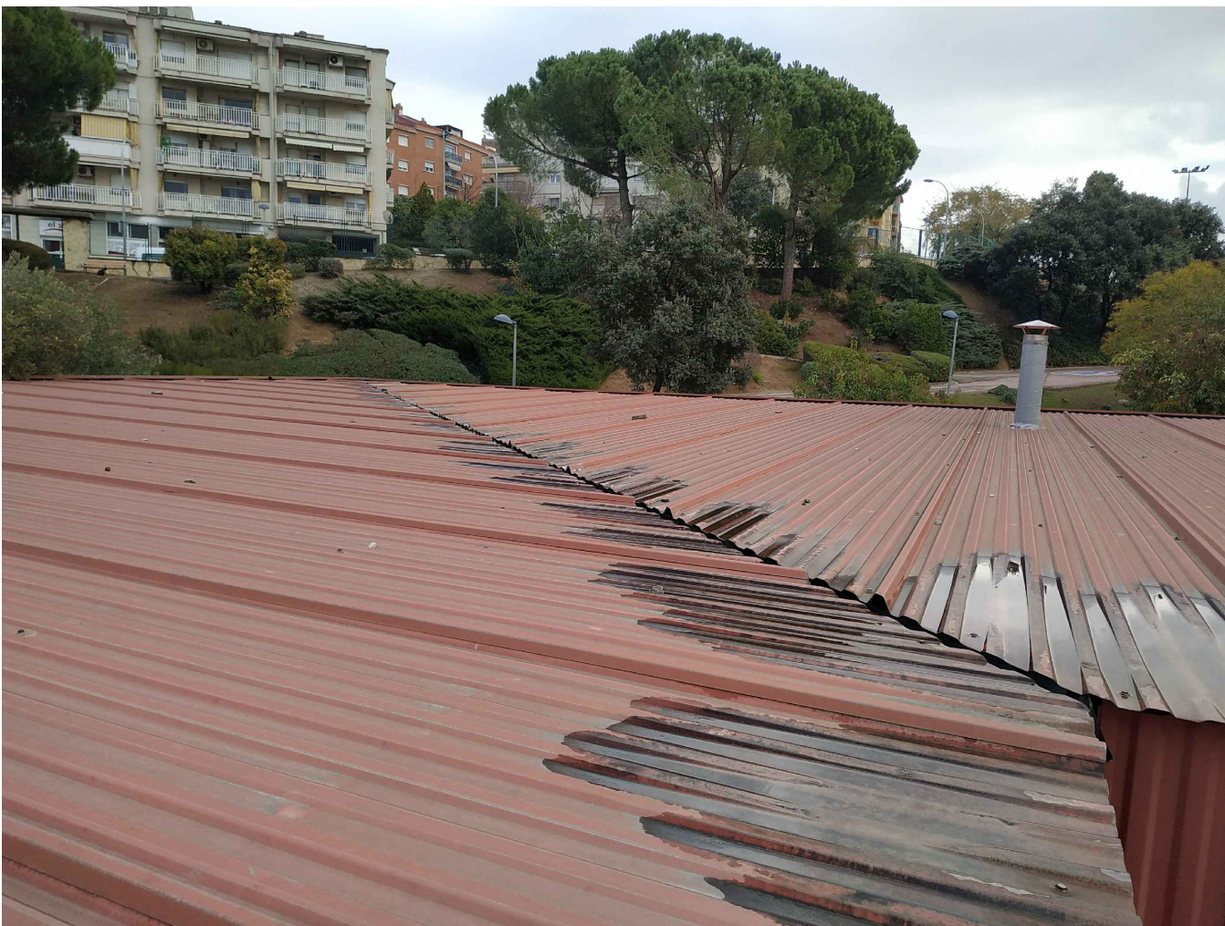
IMG. 7 - COBERTA DE L'EDIFICI
