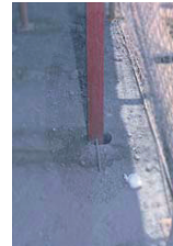
Recolzament inferior sostre
