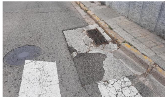
Imatges de diverses patologies del carrer
