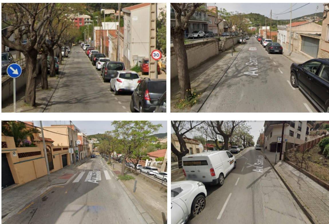
Imatges de diverses patologies del carrer
