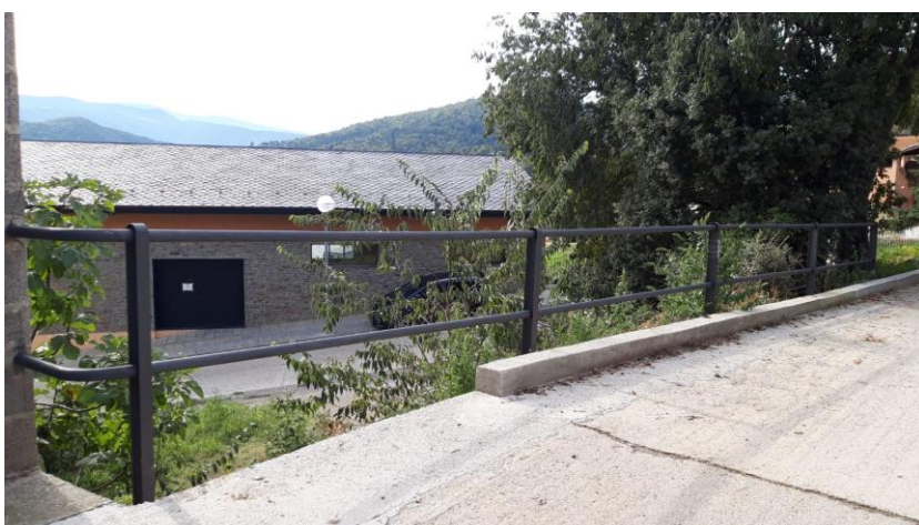
FOTO 2: Vista de barana existent - ARAVELL
