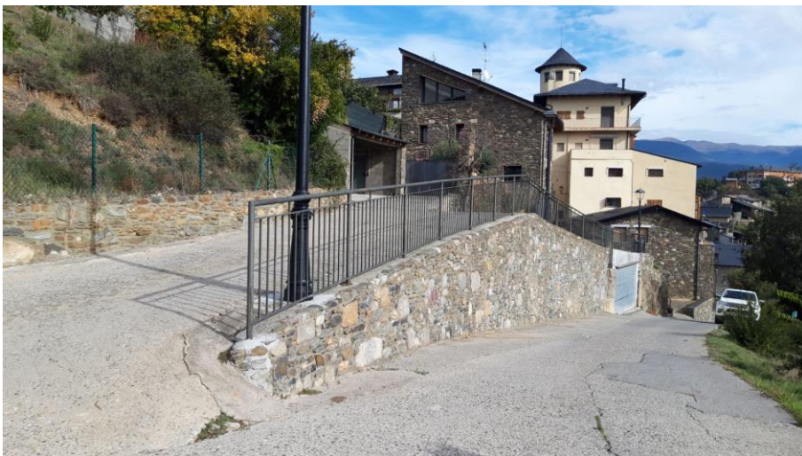
FOTO 9: Vista de barana tipus - MONTFERRER
