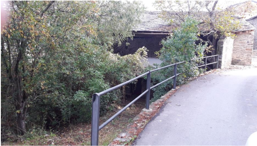
FOTO 7: Vista de barana existent - MONTFERRER
