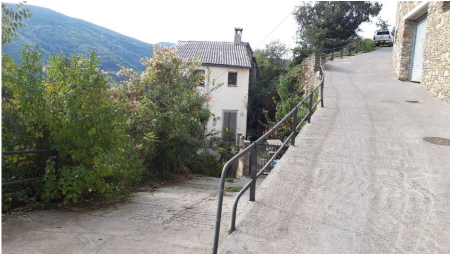
FOTO 8: Vista de barana existent - MONTFERRER
