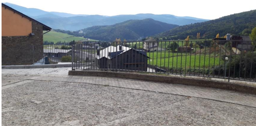
FOTO 3: Vista de barana tipus - ARAVELL
