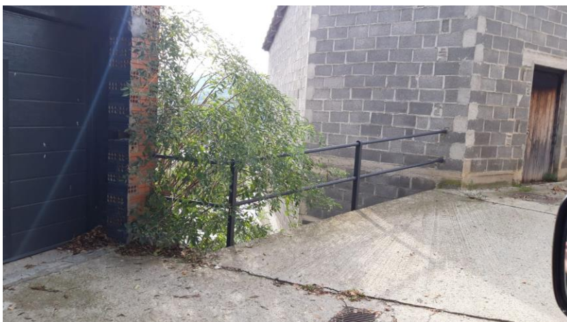
FOTO 1: Vista de barana existent - ARAVELL
