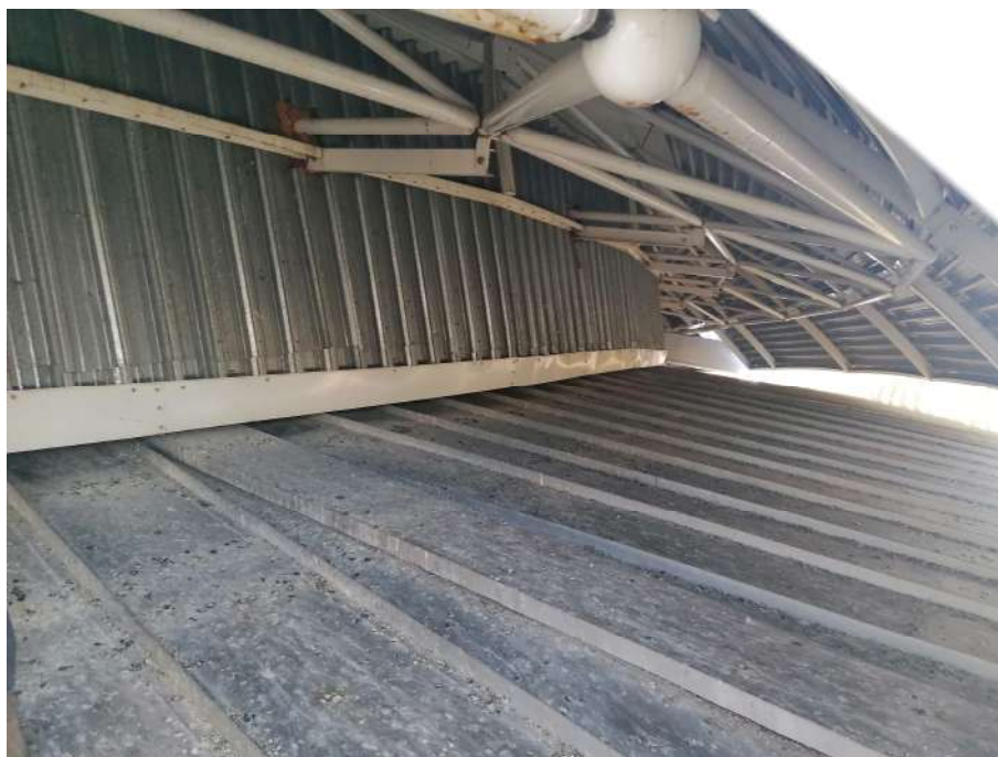
Imatges de la coberta de la Tarraco Arena Plaça
