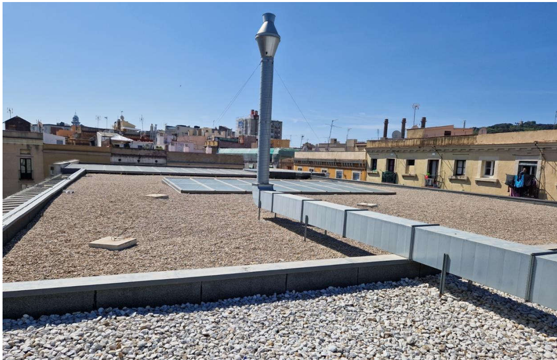
Foto 1. Detall coberta, zona xemeneia
