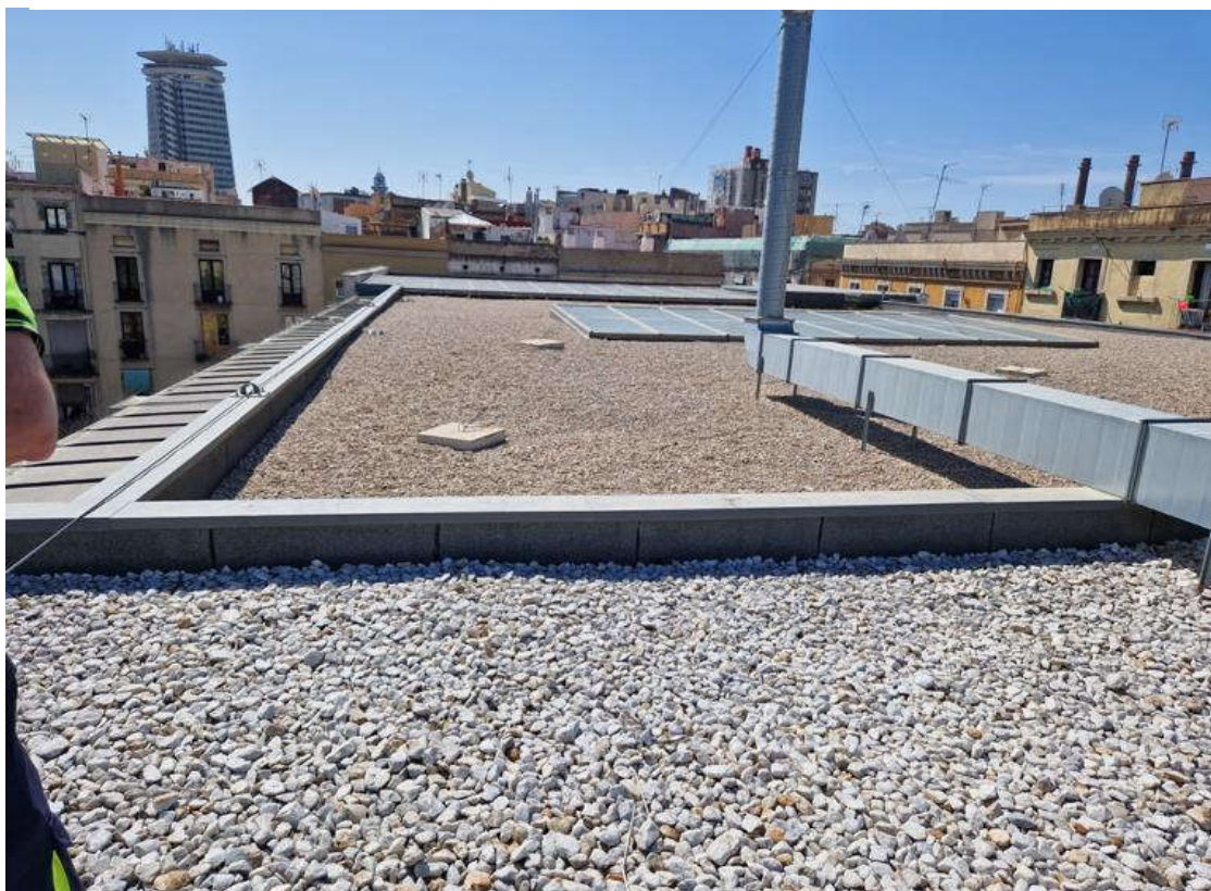
Foto 2. Detall tensors subjecció xemeneia
