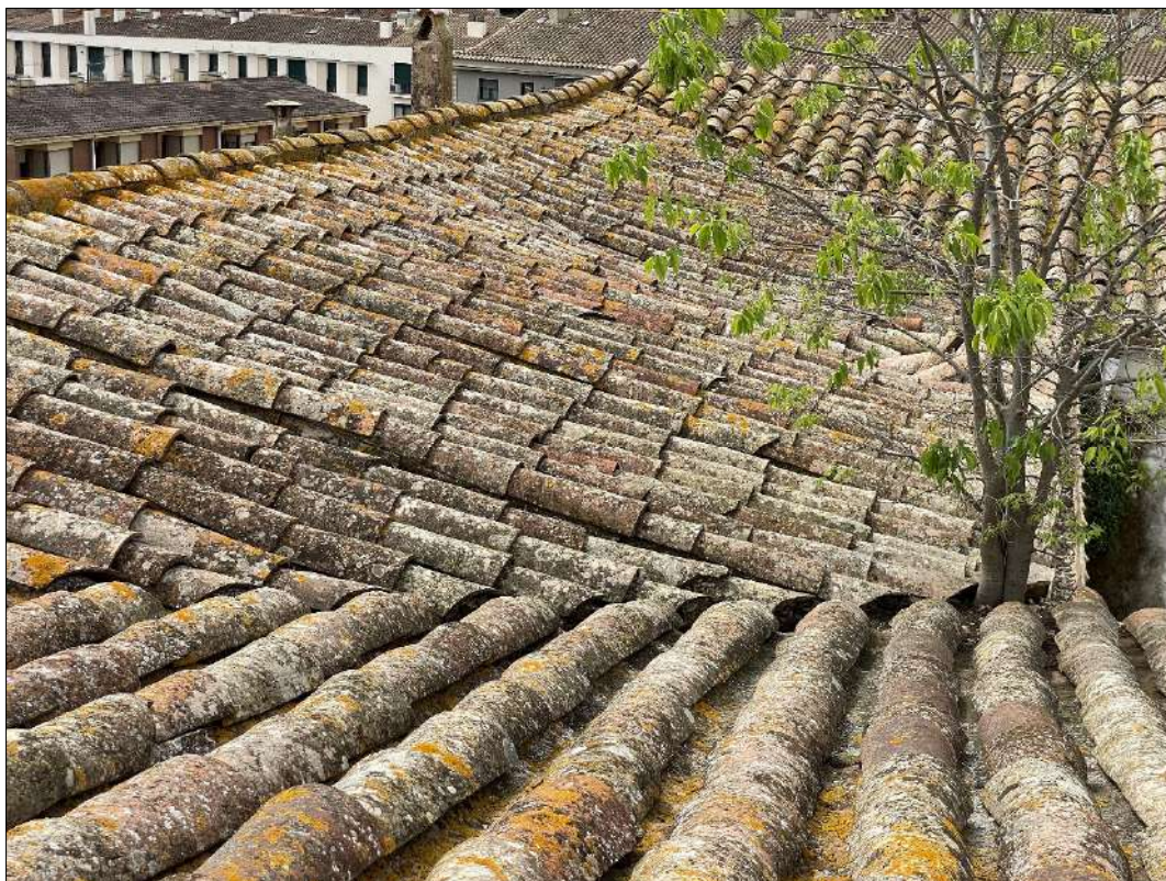
Zona a intervenir en coberta 01.
