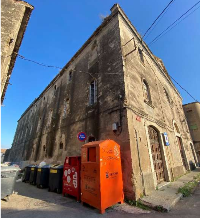
Vista del punt de recollida de residus al carrer de la Constància.
