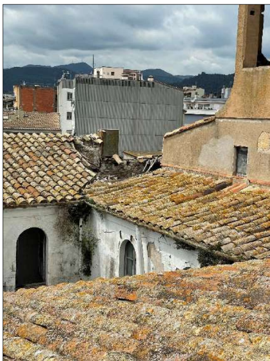
Zona a intervenir en coberta 03.
