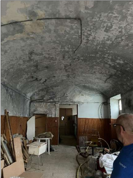
Volta en planta baixa amb humitats a apuntalar.
