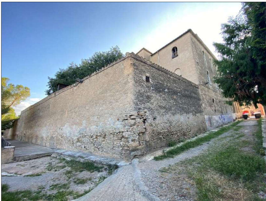
Vista de la façana posterior des del carrer de la Constància.
