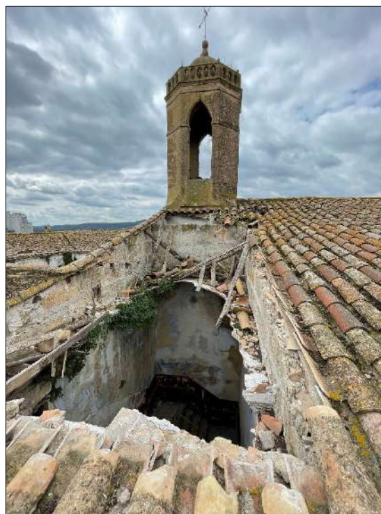
Zona a intervenir en coberta 05.
