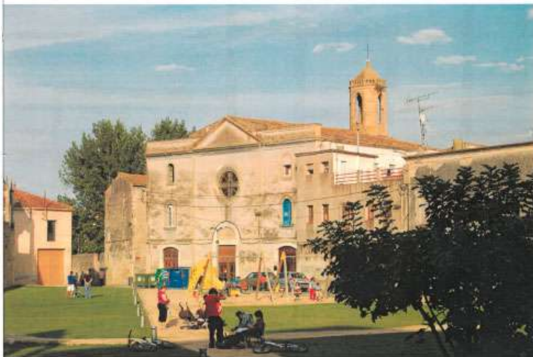
FAÇANA PRINCIPAL DE LA PROVIDÈNCIA
