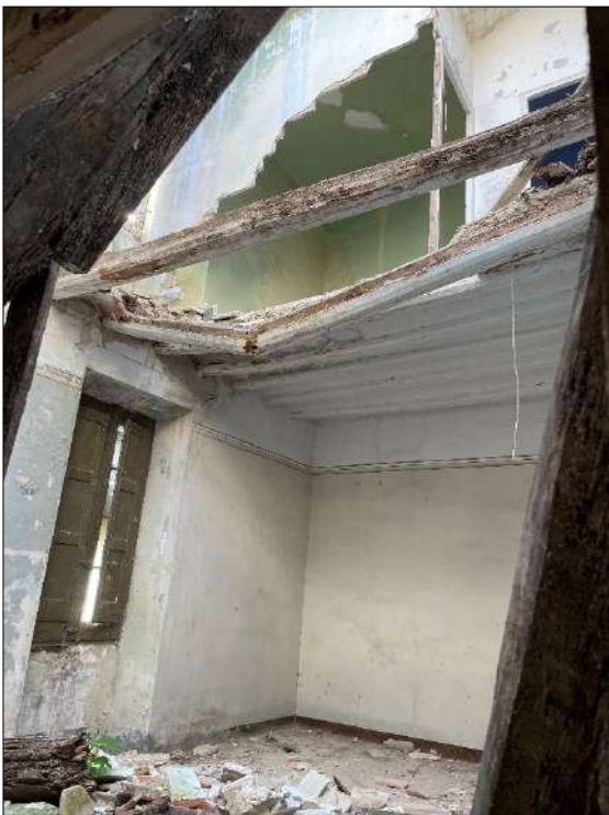
Forjat a acabar d'enderrocar.
