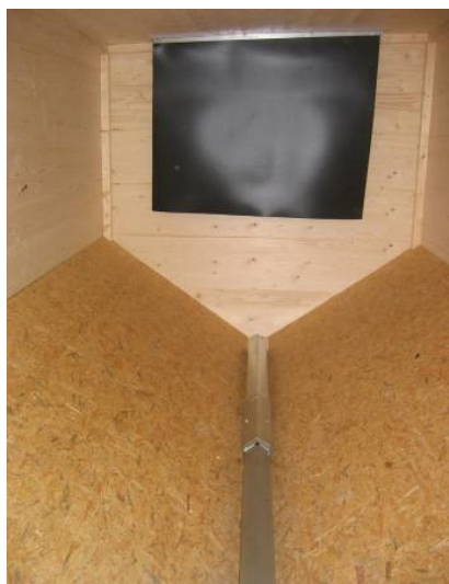
Figura 2. Vista interior d'una sitja prefabricada en fusta. S'hi poden apreciar les rampes que condueixen el pèl·let al vis que es troba a la part central, a més de la lona amortidora.
