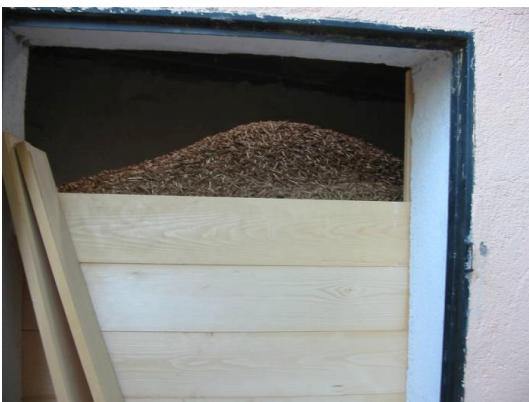
Figura 6. Accés a una sitja d'obra. Les fustes són sempre necessàries per possibilitar el registre quan la sitja està carregada totalment o parcialment.
