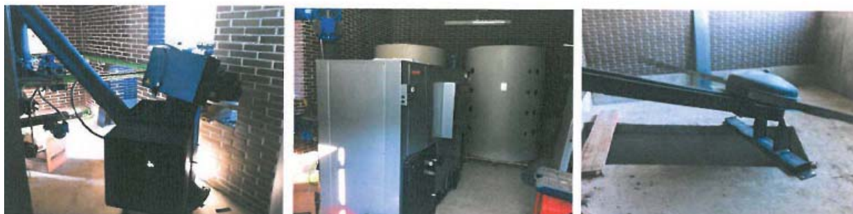
Imatge 4: Imatges d'obra
