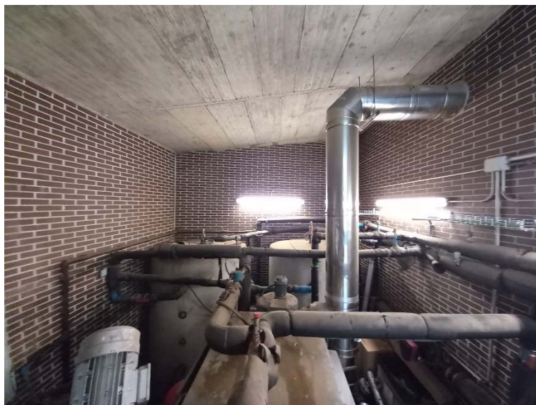
Imatge 5: Imatge Superior Sala Calderes
