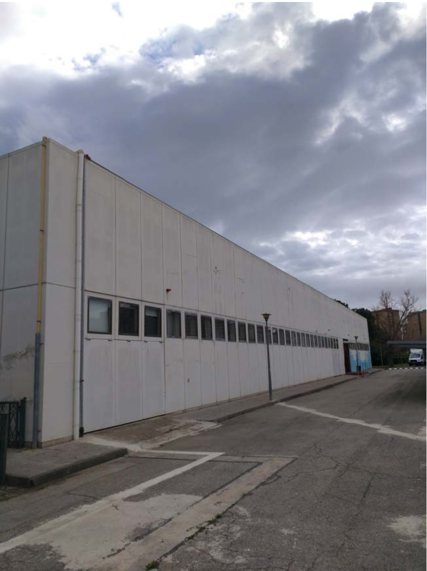
FAÇANES CIFO. PORTES A SUBSTITUIR. CONDUCCIÓ DE GAS A DEIXAR VENTILADA. SIRENES I CÀMERES A MANTENIR
