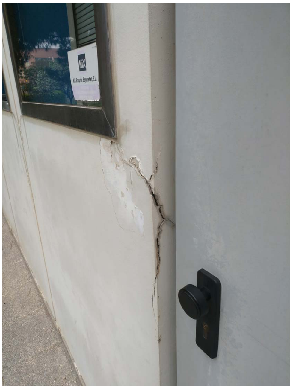
AFECTACIÓ DE PLAFONS TIPUS B: ESQUERDES SUPERFICIALS. ACTUACIÓ: SEGELLAT D'ESQUERDES AMB MORTER SENSE RETRACCIÓ PRÈVIA APLICACIÓ DE PONT D'UNIÓ
