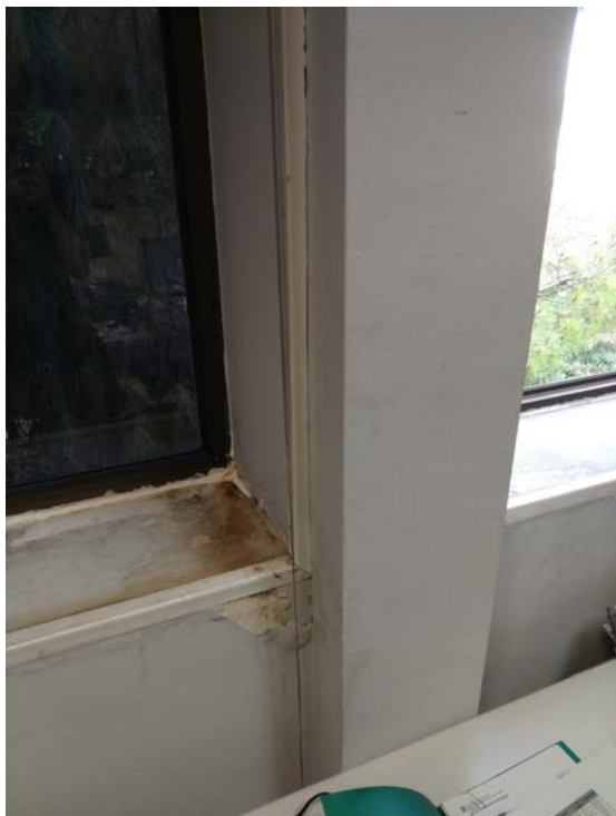
Interior de façana amb diversos punts d'entrada d'aigua
