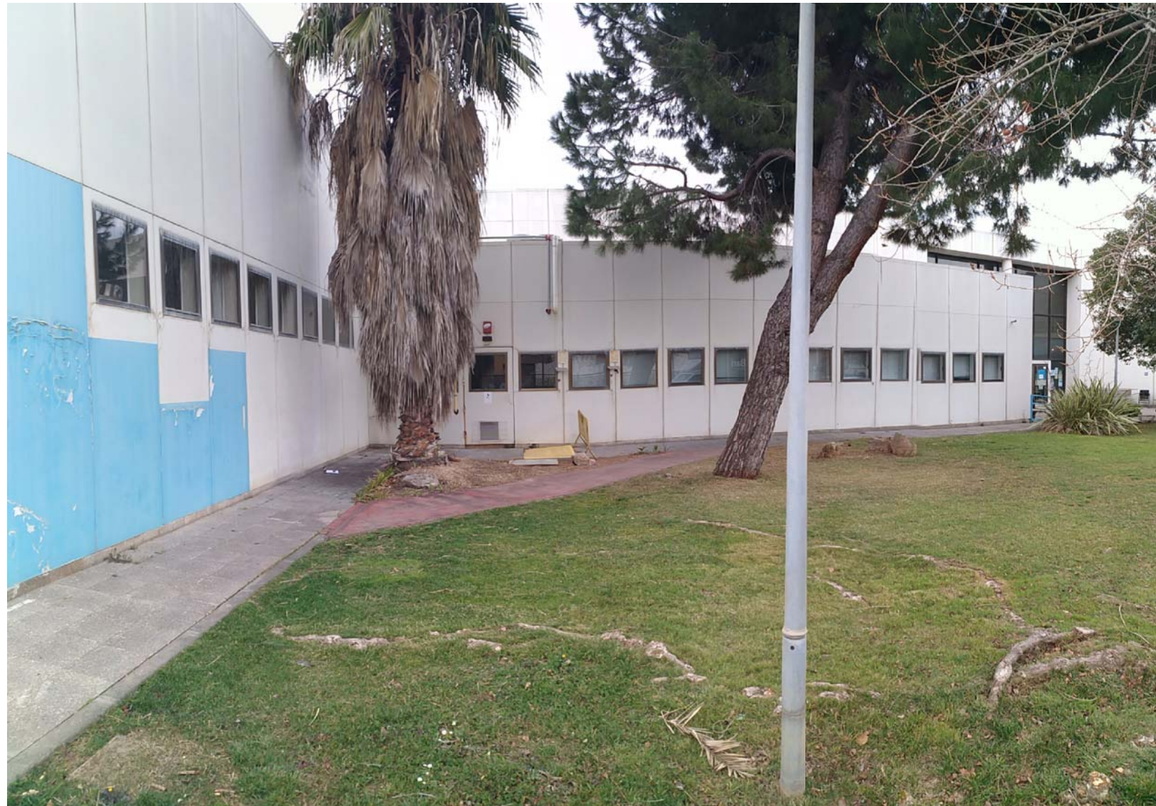
PALMERA A ZONA D'INSTAL·LACIONS, A RETALLAR
