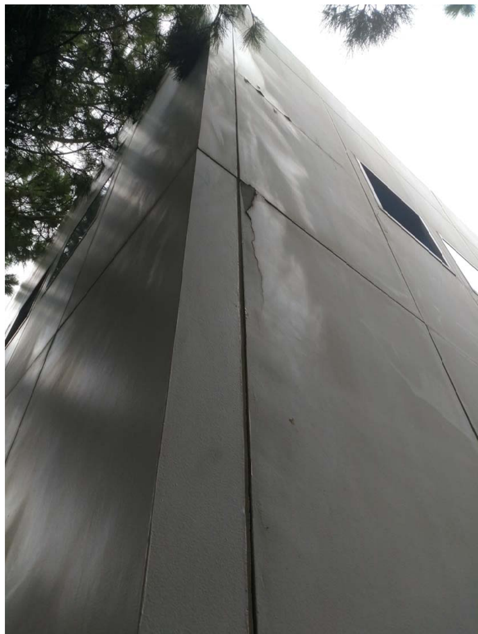
AFECTACIÓ DE PLAFONS TIPUS A: AFECTACIÓ DE CAPA SUPERFICIAL AMB DESPRENIMENT O PÈRDUA DE MATERIAL. ACTUACIÓ: PICAT DE TRAM DE PLAFÓ AMB PROBLEMES DE PLANEITAT O INTEGRITAT, PASSIVAT D'ARMADURES AL COS DE PLAFÓ I RECONSTRUCCIÓ DE VOLUM AMB MORTER SENSE RETRACCIÓ PRÈVIA APLICACIÓ DE PONT D'UNIÓ
