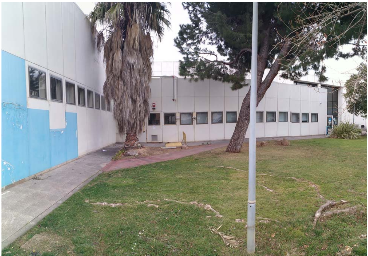
Façana prefabricada de formigó armat
