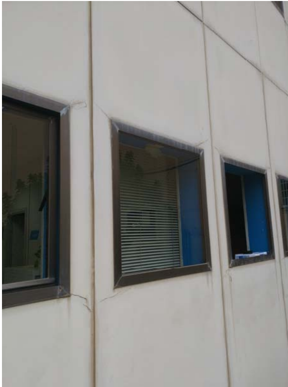
Fusteries a cara exterior de façana sense protecció.
