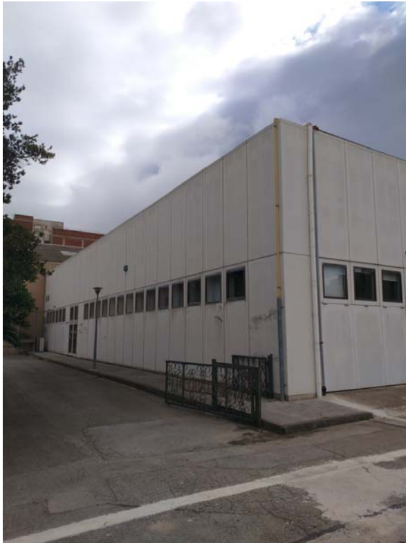
Façana prefabricat de formigó
