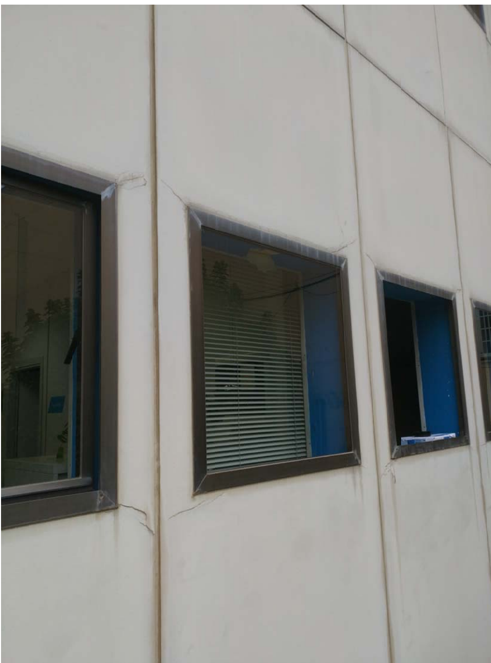
AFECTACIÓ DE PLAFONS TIPUS B: ESQUERDES SUPERFICIALS. ACTUACIÓ: SEGELLAT D'ESQUERDES AMB MORTER SENSE RETRACCIÓ PRÈVIA APLICACIÓ DE PONT D'UNIÓ
