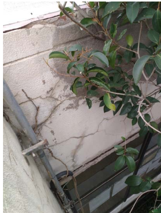
Plantes enfiladisses, esquerdes i problemes d'estanqueïtat de trobada amb fusteries pati gran
