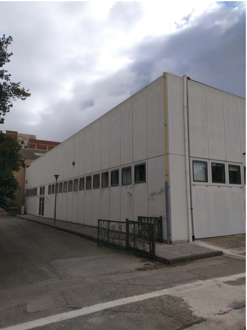
FAÇANES CIFO. PORTES A SUBSTITUIR. CONDUCCIÓ DE GAS A DEIXAR VENTILADA. SIRENES I CÀMERES A MANTENIR
