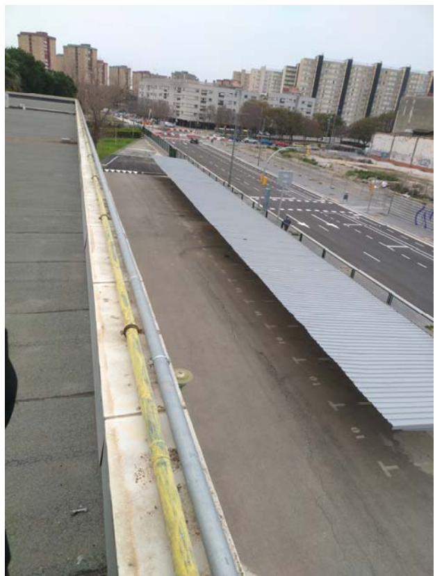
Conduccions aigua i gas en coronament façana existent
