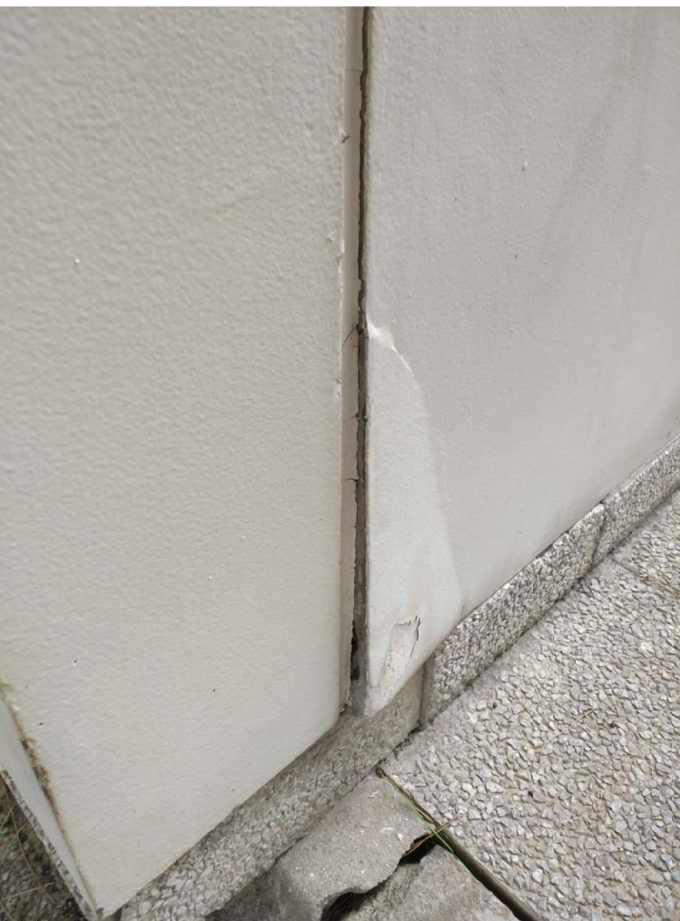
AFECTACIÓ DE PLAFONS TIPUS A: AFECTACIÓ DE CAPA SUPERFICIAL AMB DESPRENIMENT O PÈRDUA DE MATERIAL. ACTUACIÓ: PICAT DE TRAM DE PLAFÓ AMB PROBLEMES DE PLANEITAT O INTEGRITAT, PASSIVAT D'ARMADURES AL COS DE PLAFÓ I RECONSTRUCCIÓ DE VOLUM AMB MORTER SENSE RETRACCIÓ PRÈVIA APLICACIÓ DE PONT D'UNIÓ
