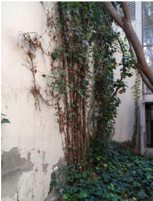
Plantes enfiladisses, esquerdes i problemes d'estanqueïtat de trobada amb fusteries pati gran
