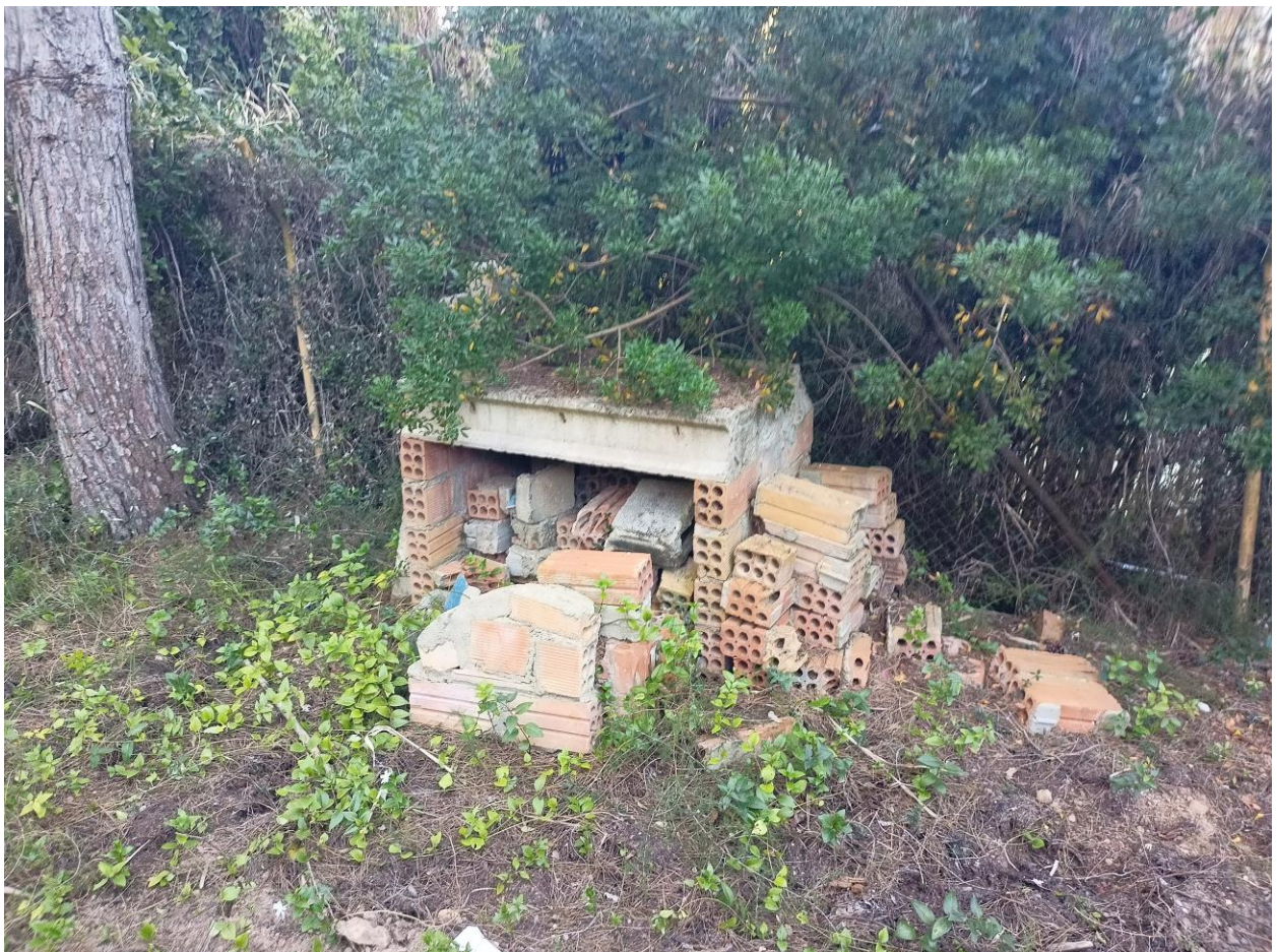
Element exterior, aïllat de l'edifici, a enderrocar.
