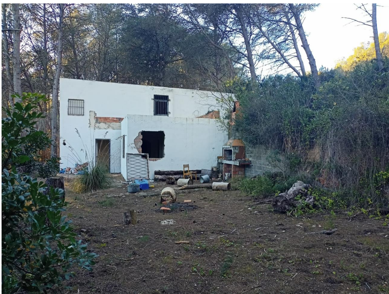
Vista general de l'edifici (façana est) des de la cota de la planta baixa.
