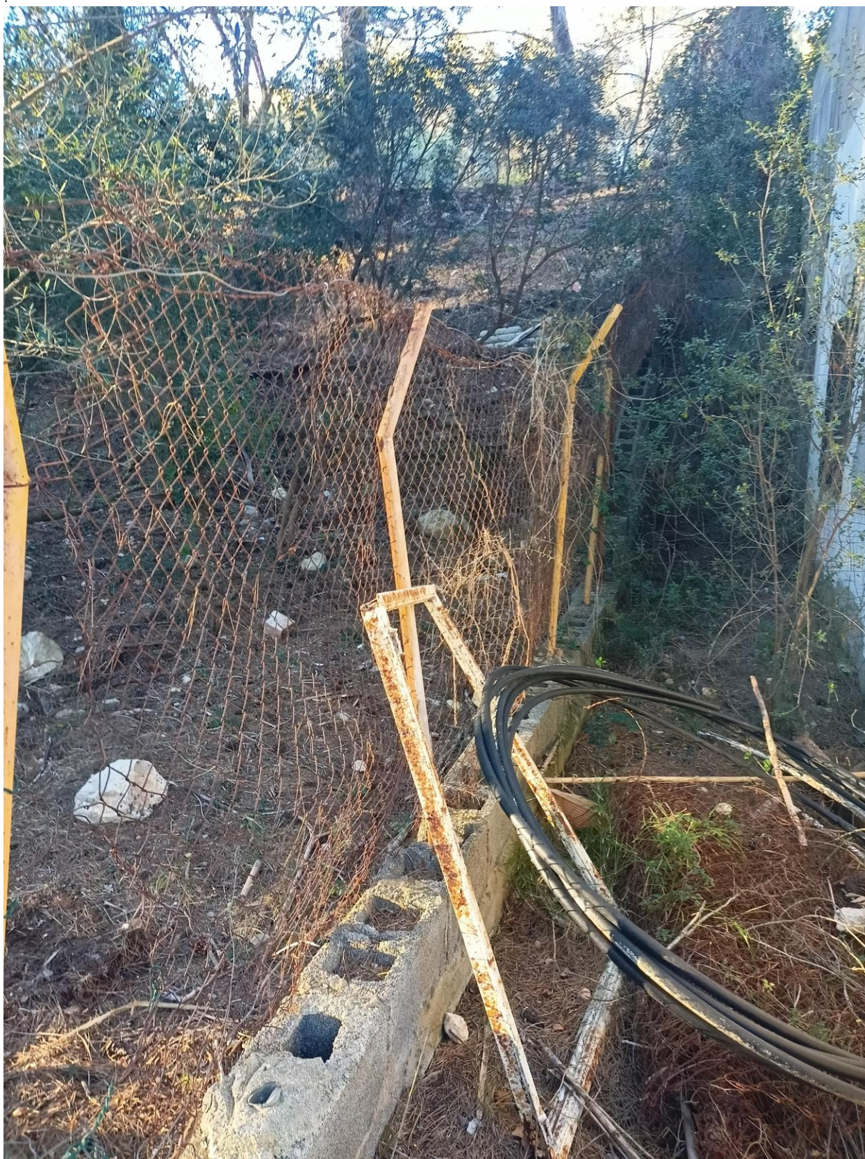
Tanca i muret a eliminar per tal de connectar l'espai exterior de l'escola de natura amb el nou espai.
