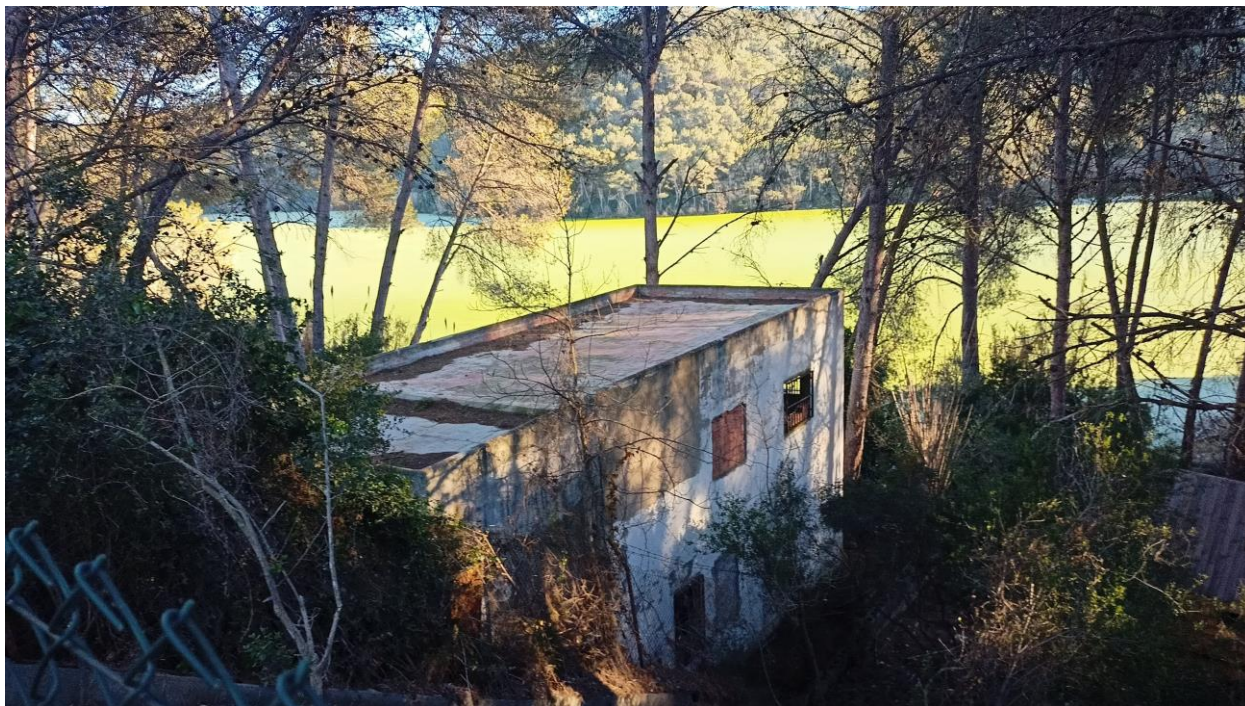
Vista de l'edifici des de l'accés a peu de carretera.
