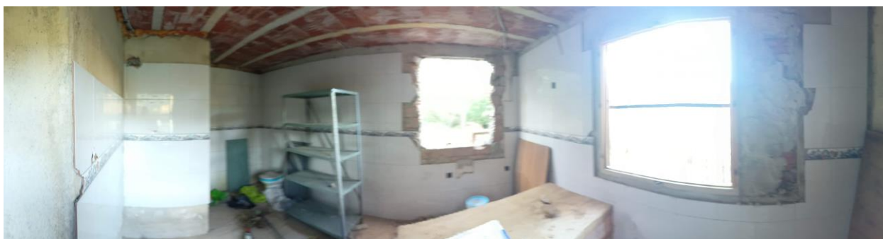
Vista interior de la planta baixa: cuina.
