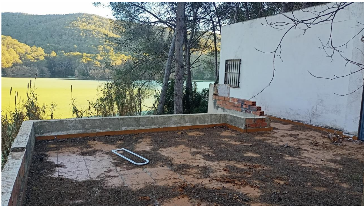
Vistes de la terrassa de la P1 i façana est, amb l'entrada a aquesta planta des de l'exterior.
