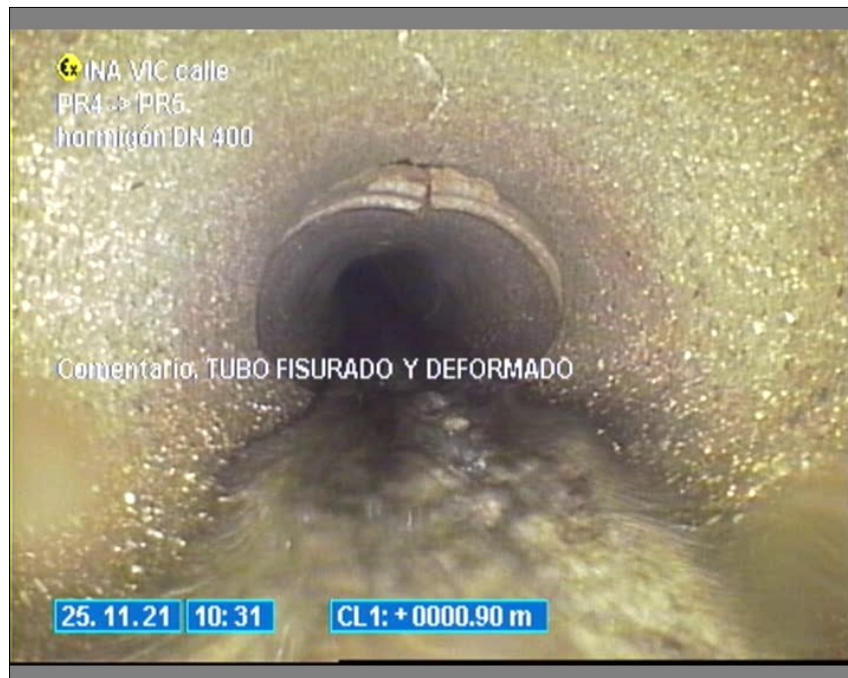
Foto: 4_2A, Medio N°: 251121_1, 00:00:04 1m, Inicio de la inspección
