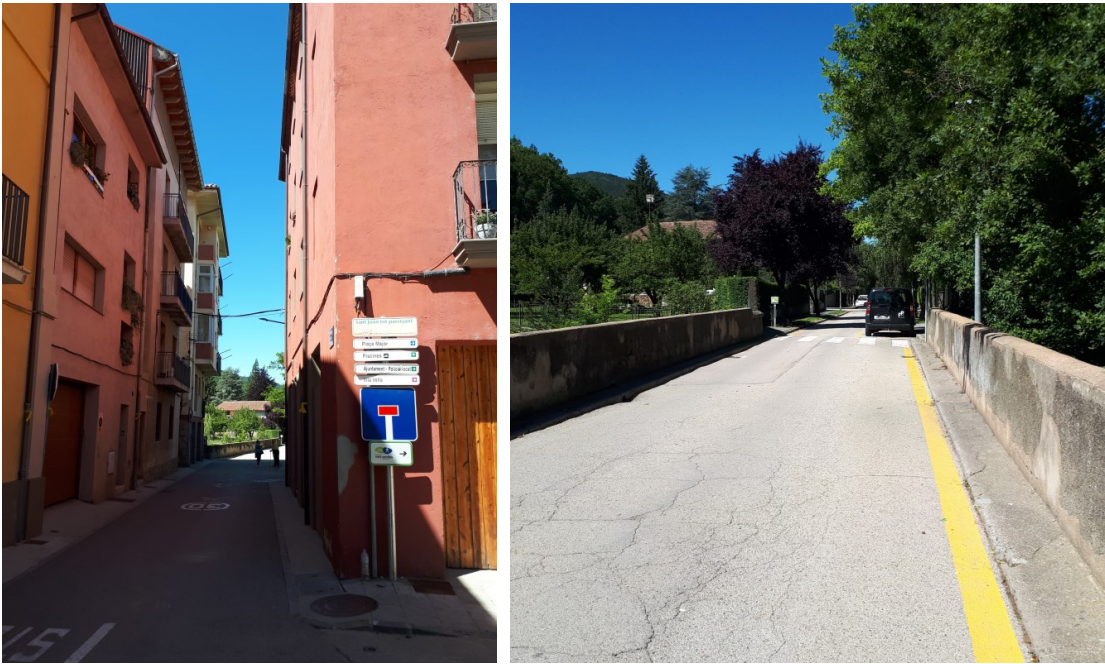
Accessos i pont de La Plana.
