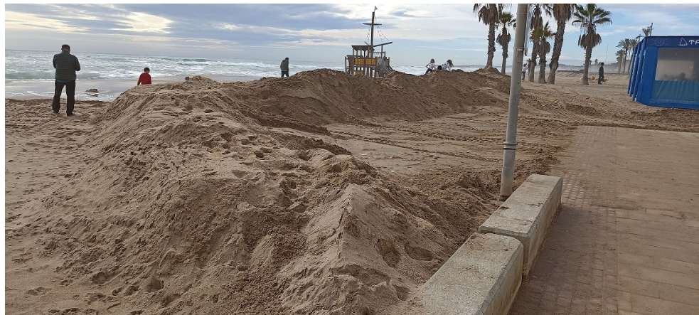
Imatge 6. Mota de sorra executada amb pala carregadora de 14TN davant de la Carretera de Sant Salvador. Divendres 3/11/2023.
