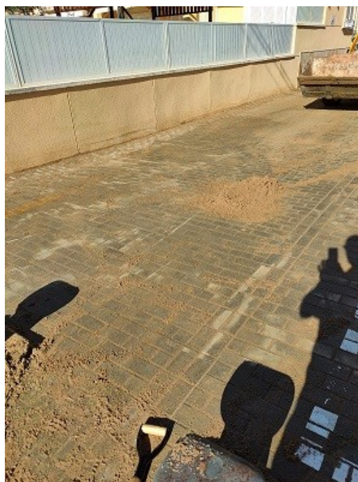
Imatge 11. Retirada de sorra del carrer Francolí amb una escombradora arrossegadora . Dilluns 6/11/2023.
