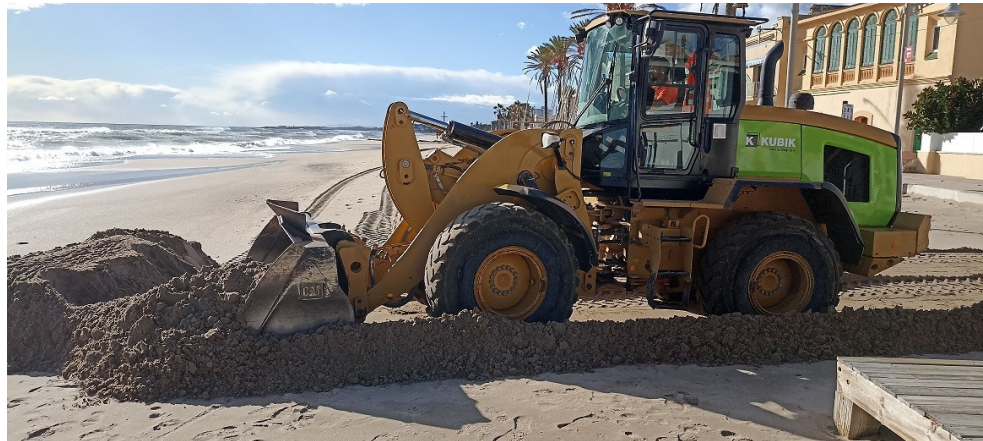
Imatge 5. Pala carregadora de 14TN executant mota de sorra a la platja davant del carrer Francolí. Divendres 3/11/2023.
