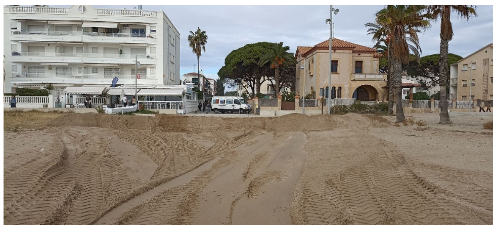
Imatge 10. Mota de sorra executada amb pala carregadora de 14TN davant del carrer Llobregat. Dissabte 4/11/2023.
