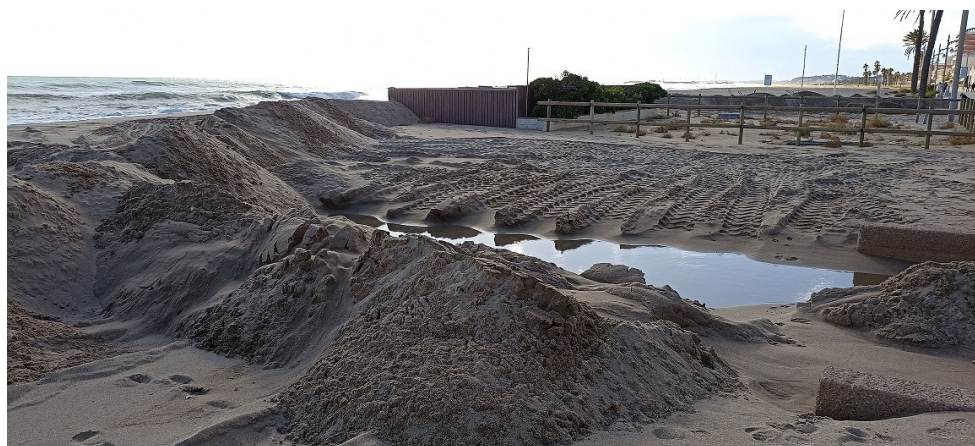
Imatge 8. Mota de sorra executada amb pala carregadora de 14TN davant de la plaça de Sant Salvador. Divendres 3/11/2023.
