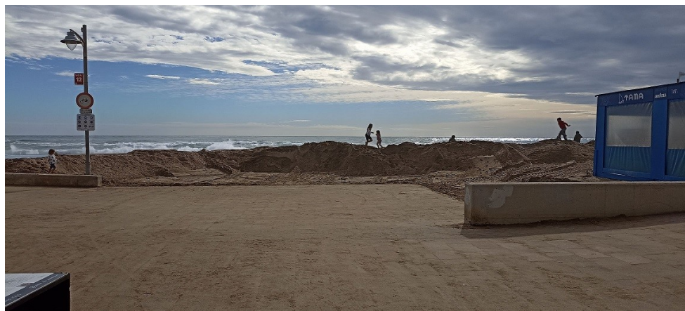
Imatge 7. Mota de sorra executada amb pala carregadora de 14TN davant de la Carretera de Sant Salvador. Divendres 3/11/2023.
