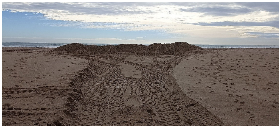
Imatge 9. Mota de sorra executada amb pala carregadora de 14TN davant del carrer Llobregat. Dissabte 4/11/2023.
