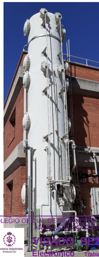
Figura 8. Desulfurador existente
