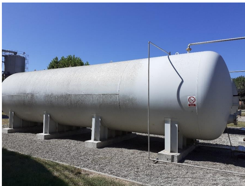
Figura 6. Gasómetros existentes a desmontar y achatarrar.
