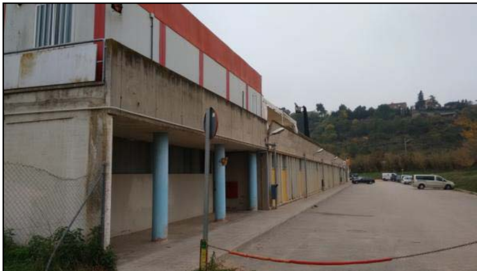
Accés a la sala tècnica del camp de futbol
