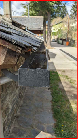
Canal metàl·lica existent
