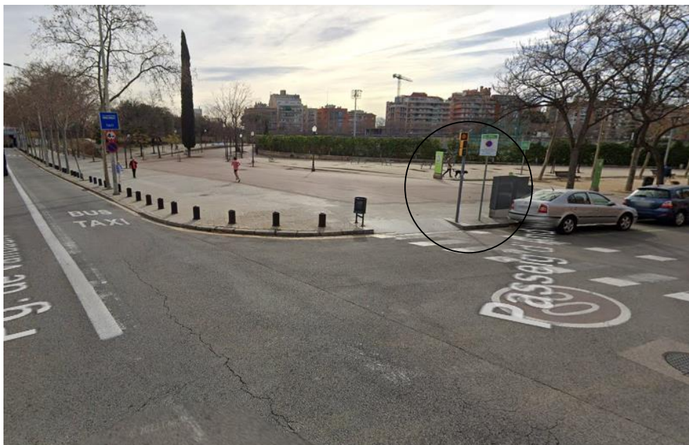
Armari comandament i escomesa existent
