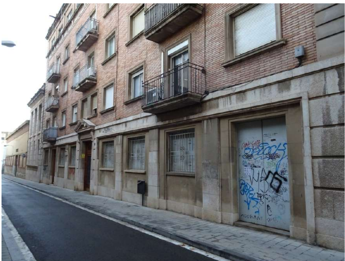
FAÇANA CARRER DE JOSEP ANSELM CLAVÉ. ENTRADA MAGATZEMS 1 (dreta) I 3 (esquerra)
