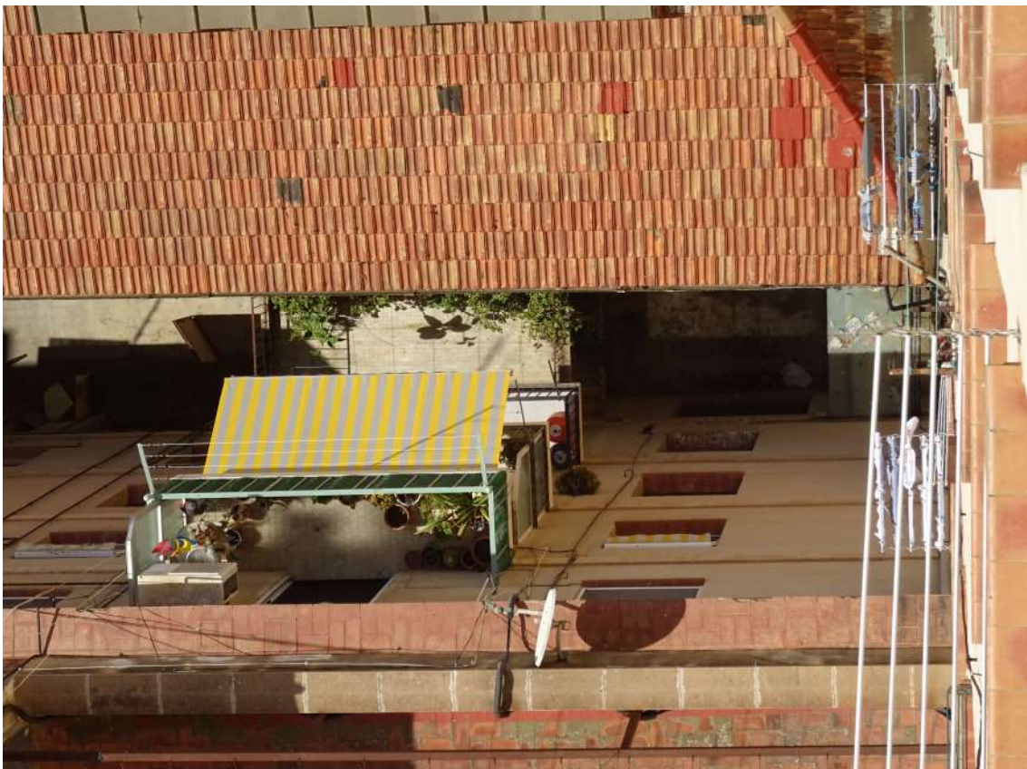
PATI ACCÉS MAGATZEM 1, OFFICE I MAGATZEM 2
