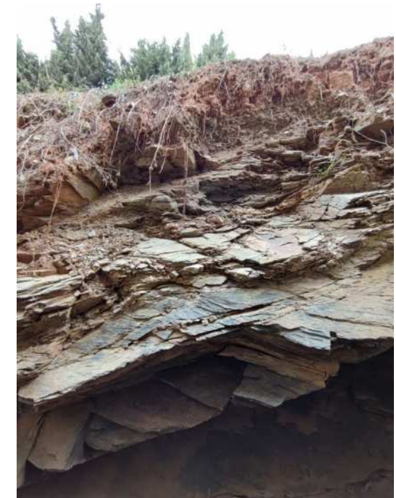
Imatge 4.2. Detall de la zona on s'han disgregat les pissarres.
