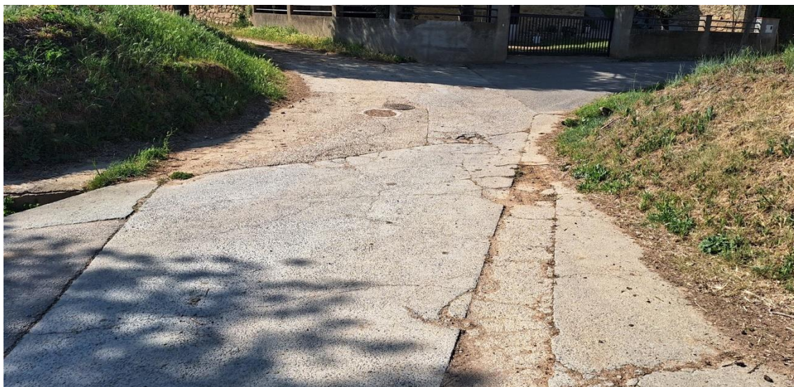
Fotografia 2_Detall del pas de la riera vista des de l'est.
