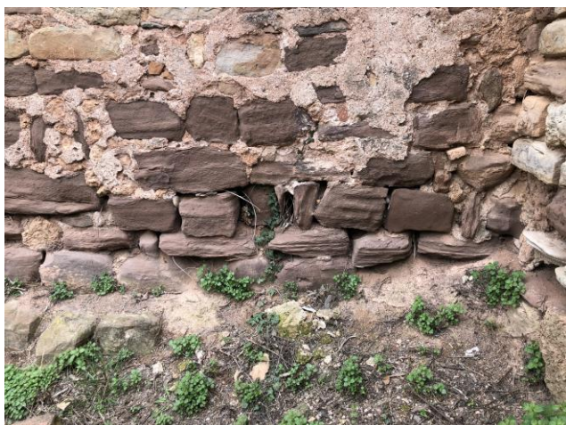
Imatges 29 i 30. Exemples de zones afectades per l'erosió i pèrdua de morters de juntes, que també van acompanyades en alguns casos d'erosió i pèrdua de material de les pedres de paredar del mur.
