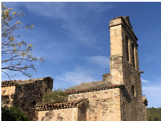
Imatges 25 i 26. Aspecte general de les zones amb inestabilitats als ràfecs de les cobertes, i als coronaments del campanar en espadanya.
