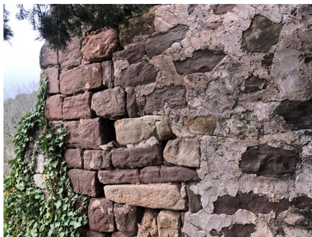
Imatges 21 i 22. Aspecte general de les esquerdes i fissures a un tram de façana sud-est, i a un contrafort de l'extrem nord-oest, respectivament.
