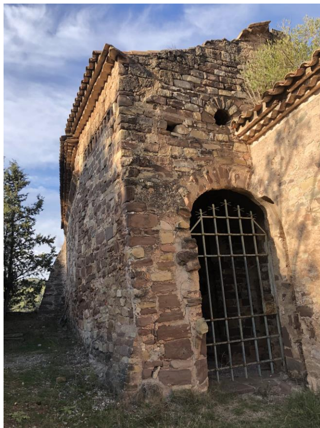
Imatges 19 i 20. Aspecte general de les esquerdes i fissures a la cantonada sud-oest des de dos punts de vista.
