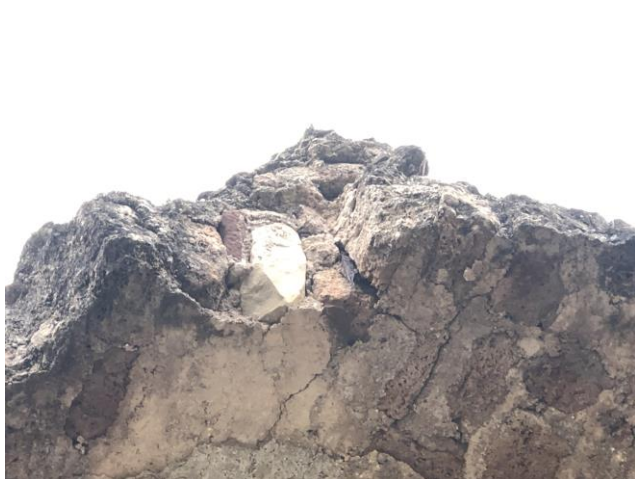
Imatges 23 i 24. Aspecte de zones amb inestabilitats de les fàbriques a les vores de la volta esfondrada de la nau romànica.
