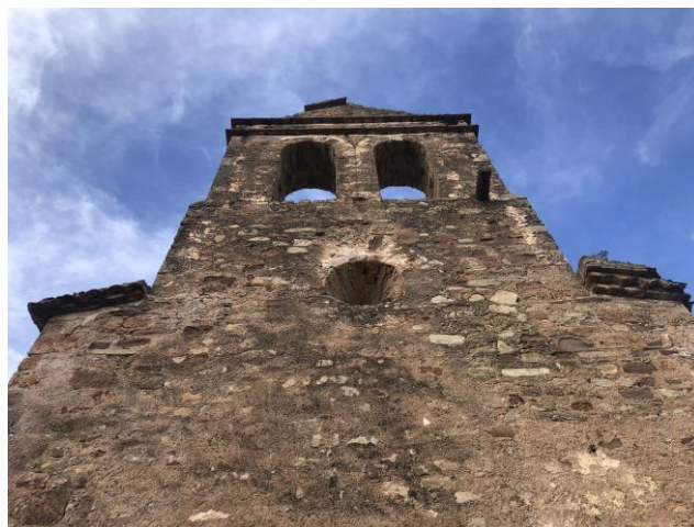
Imatges 25 i 26. Aspecte general de les zones amb inestabilitats als ràfecs de les cobertes, i als coronaments del campanar en espadanya.
