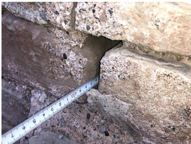
Imatges 27 i 28. Exemples de juntes de murs amb pèrdues evidents de morter.
