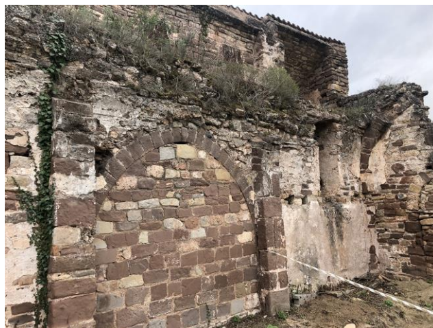
Imatges 23 i 24. Aspecte de zones amb inestabilitats de les fàbriques a les vores de la volta esfondrada de la nau romànica.
