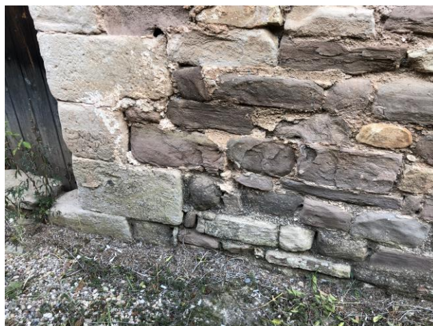
Imatges 29 i 30. Exemples de zones afectades per l'erosió i pèrdua de morters de juntes, que també van acompanyades en alguns casos d'erosió i pèrdua de material de les pedres de paredar del mur.
