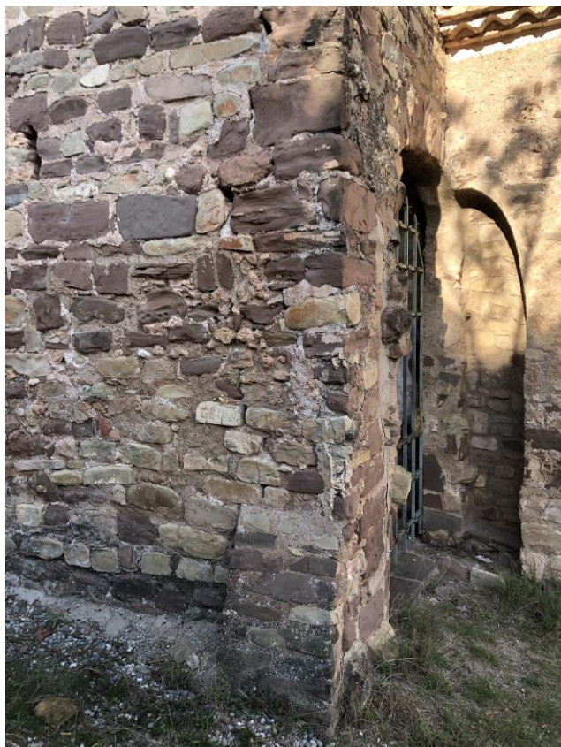
Imatges 19 i 20. Aspecte general de les esquerdes i fissures a la cantonada sud-oest des de dos punts de vista.
