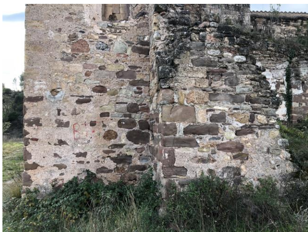
Imatges 21 i 22. Aspecte general de les esquerdes i fissures a un tram de façana sud-est, i a un contrafort de l'extrem nord-oest, respectivament.
