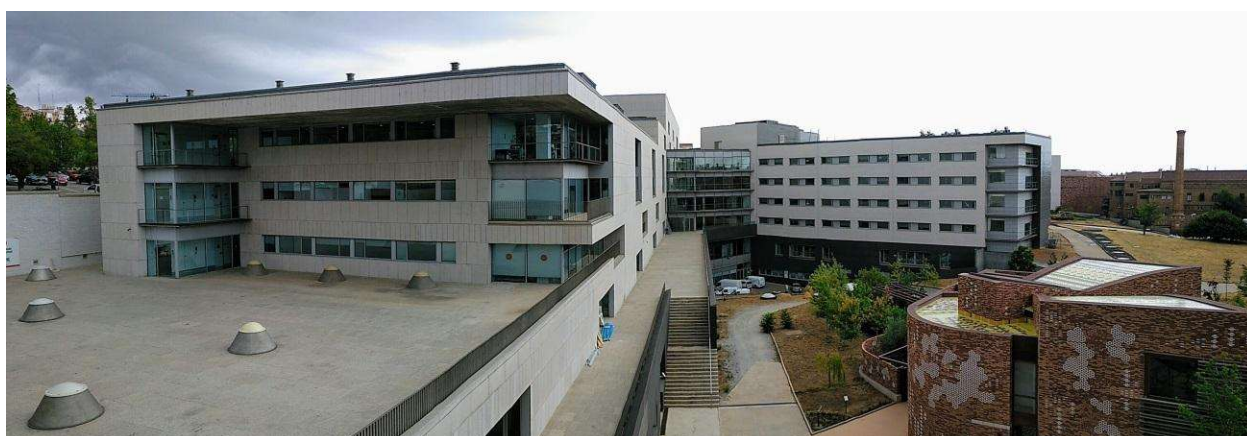
Blocs A i B
