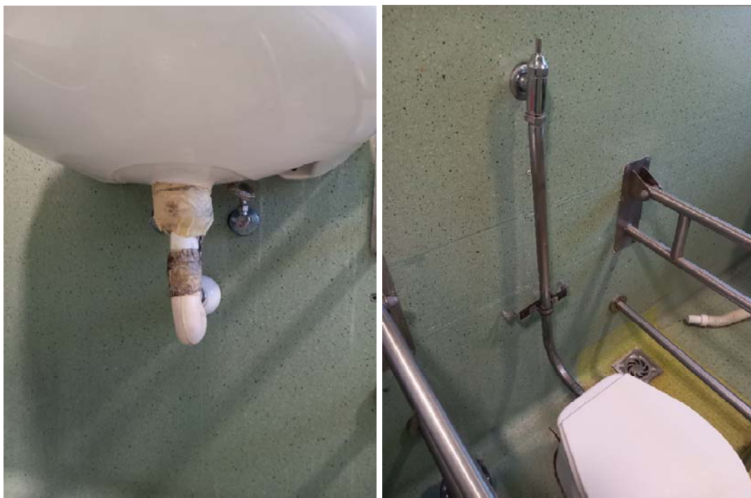
Detalls de l'estat de les instal·lacions
