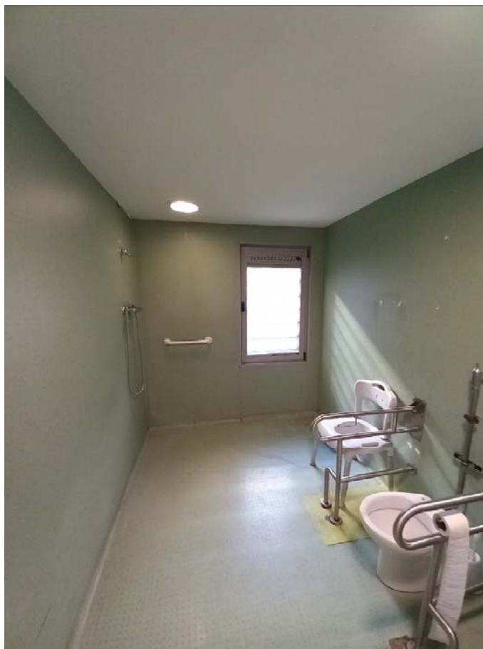
Imatge C4: Imatge de conjunt bany dret
