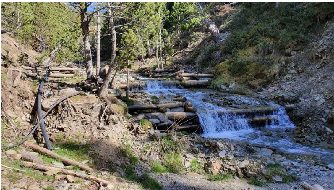
Entramats de fusta al barranc de Port Ainé
