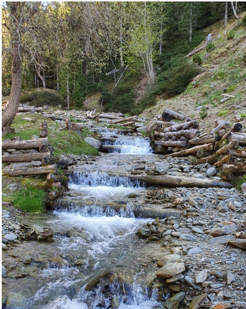
Entramats de fusta al barranc de Port Ainé
