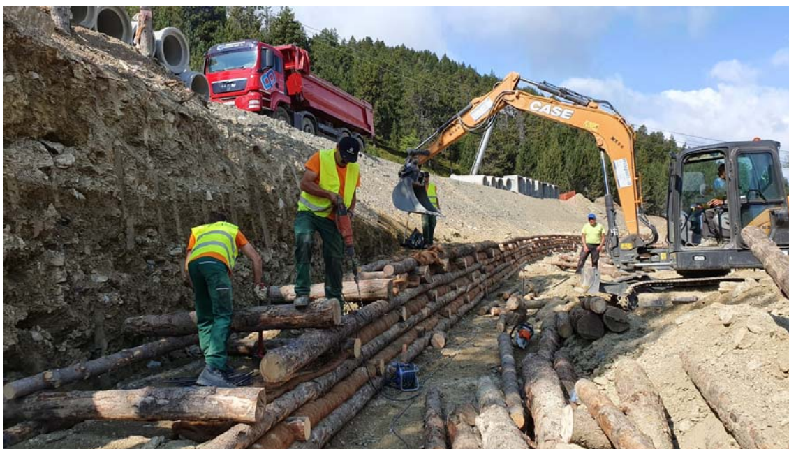
Exemple de construcció d'entramats de fusta
