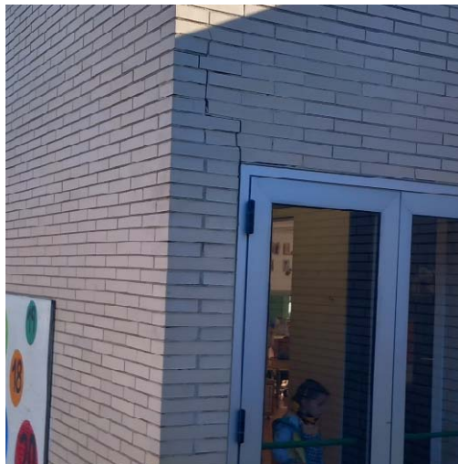
Fotografia 15: Fissures Tancament
