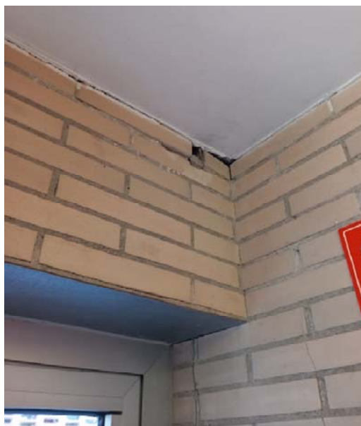
Fotografia 16: Fissures Interiors
