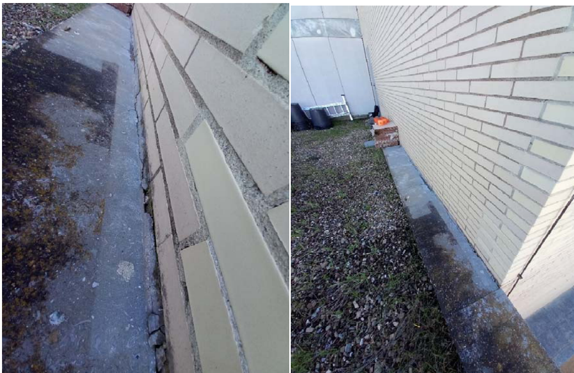
Fotografia 10: Junta de façana
