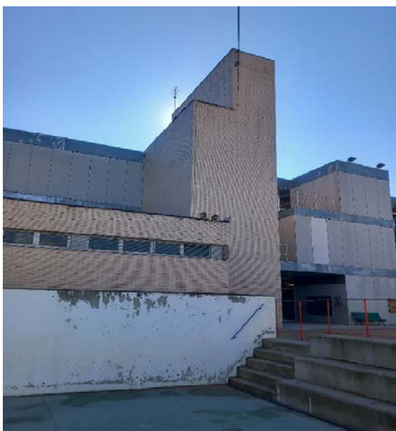
Fotografia 1: Imatge de la torre de l'escala
