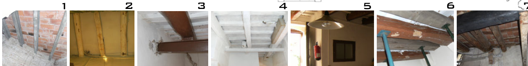
Traster_1: Forjat unidireccional de bigues de formigó. Està en perfecte estat. Forma part de l'ampliació de la casa
