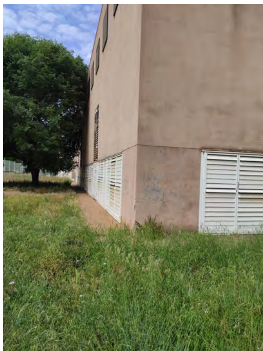
Montigalà – Façana sud-est
