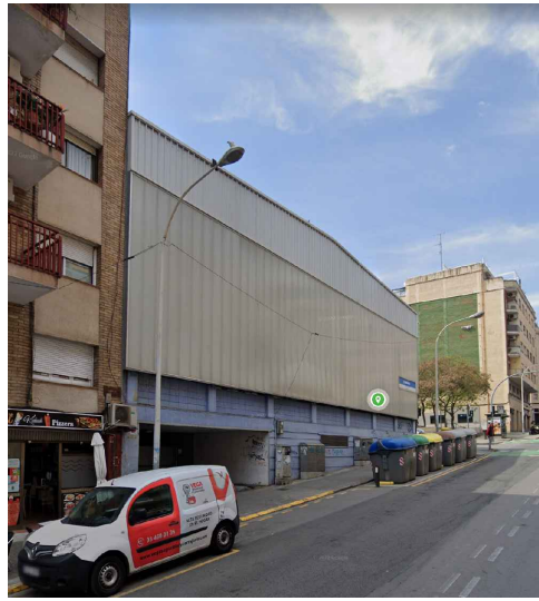
Fotografia façana Coll i Pujol
