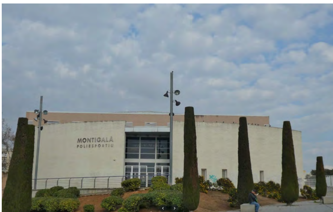
Montigalà – Façana sud-oest
