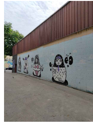
Fotografia façana Veneçuela
