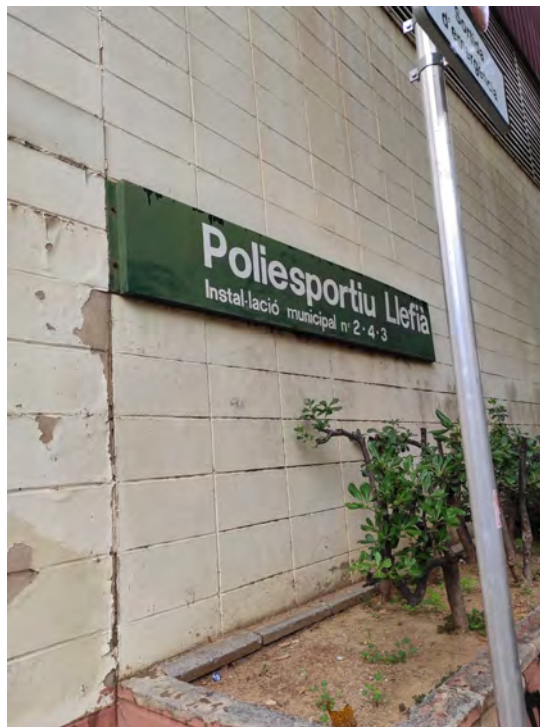
Llefià – Retolació a substituir
