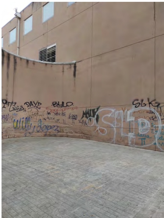
Montigalà – Façana nord-oest
