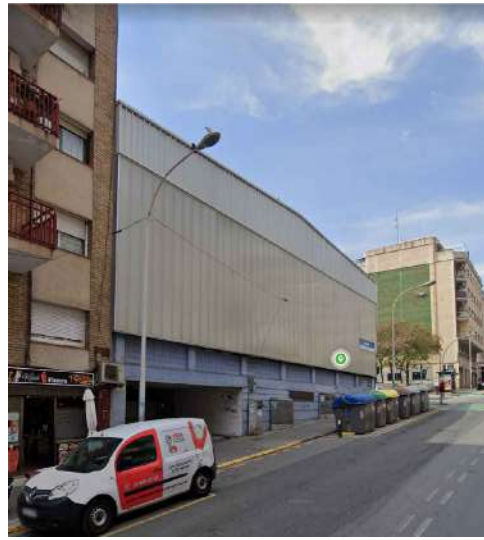
Fotografia façana Coll i Pujol
