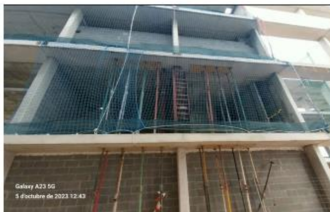
Pilars apuntalats a refer i proteccions col·lectives a assegurar
