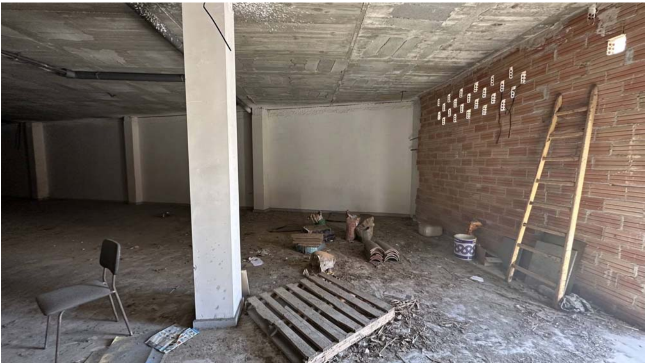
VISTA INTERIOR DEL LOCAL. ZONA DE TROBAMENT DE FAÇANA AMB MITGERA
