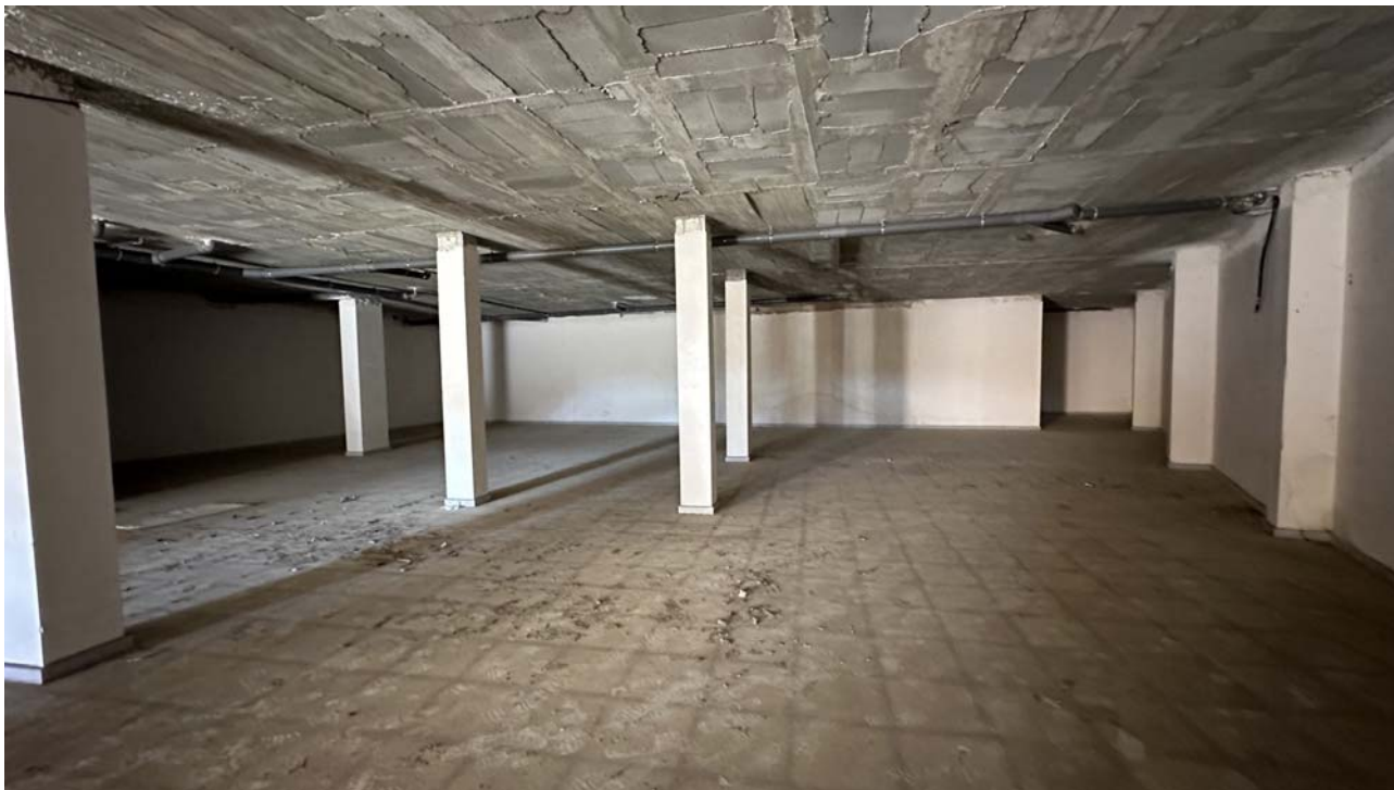
VISTA INTERIOR DEL LOCAL. ZONA NORD
