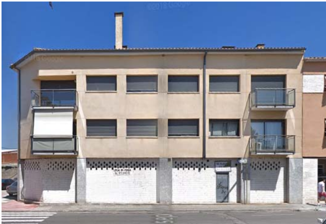
FAÇANA NORD EST, CARRER RENTADORS
