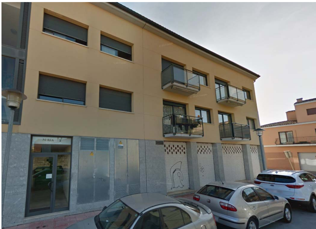
FAÇANA SUD EST, CARRER NÚRIA
