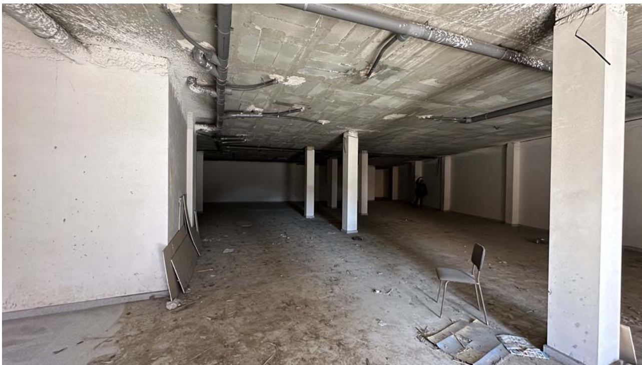
VISTA INTERIOR DEL LOCAL. ZONA NORD
