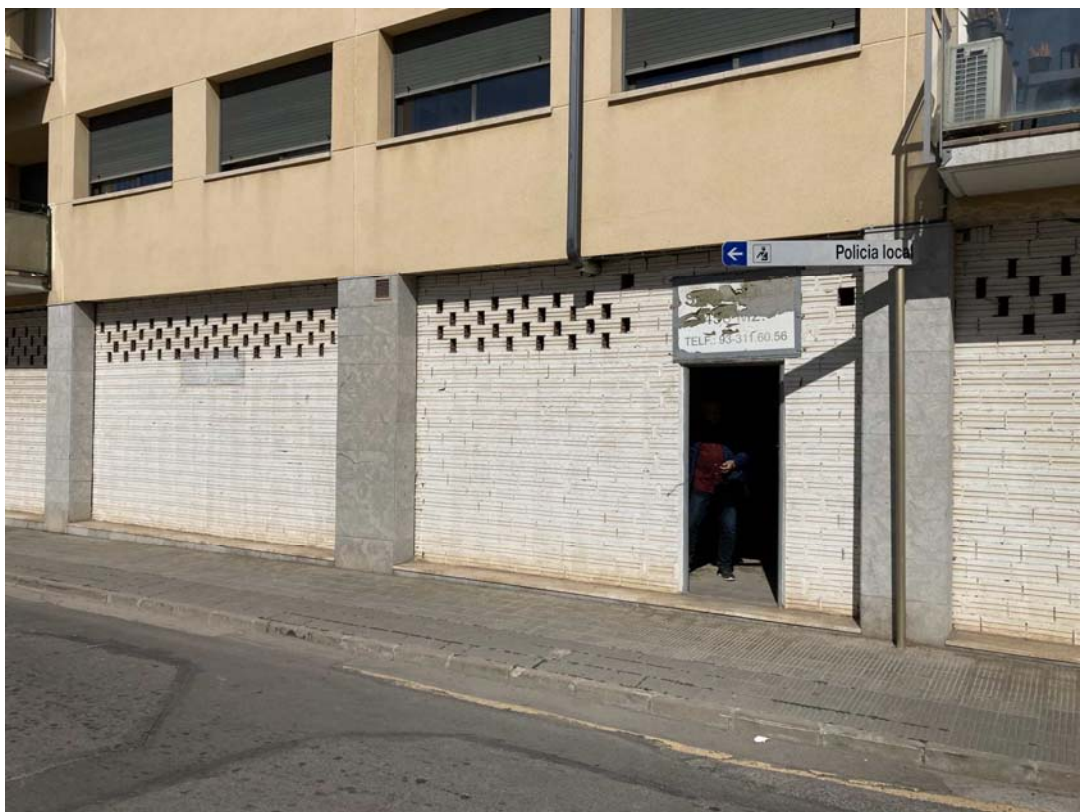
FAÇANA CARRER RENTADORS I ACCÉS ACTUAL AL LOCAL
