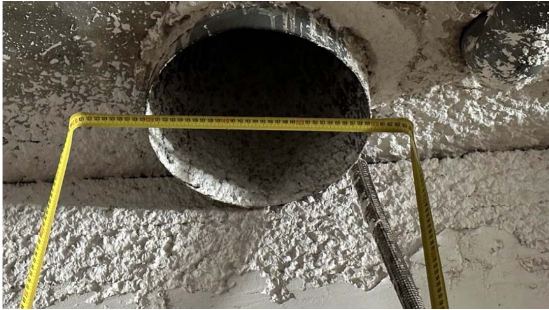
CONDUCTE EXISTENT DE VENTILACIÓ FINS A COBERTA
