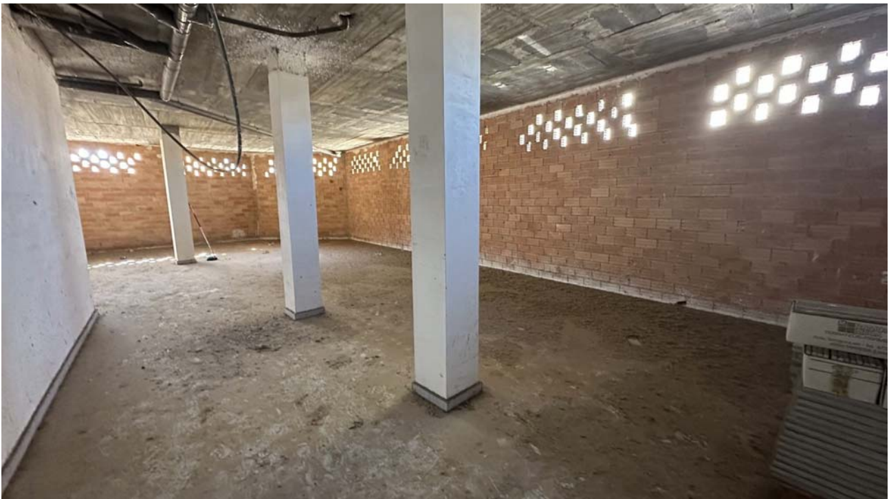
VISTA INTERIOR DEL LOCAL, AMB EL TANCAMENT DE TOTXANA
