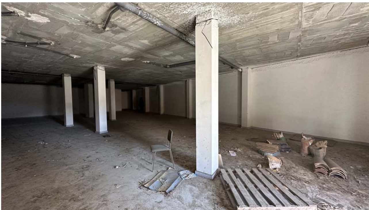
VISTA INTERIOR DEL LOCAL. ZONA NORD
