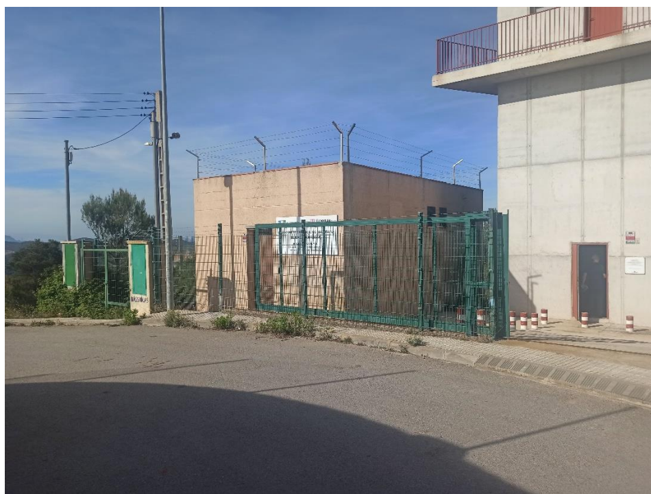
Figura A3.3 – Vista general de l'edifici auxiliar del radar de PBE
