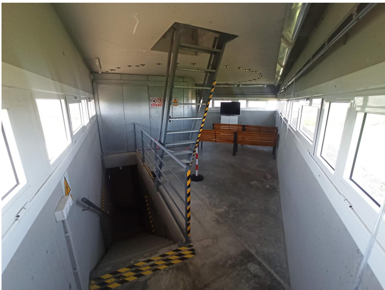
Figura A3.23 – Sala de visites del radar de CDV.
