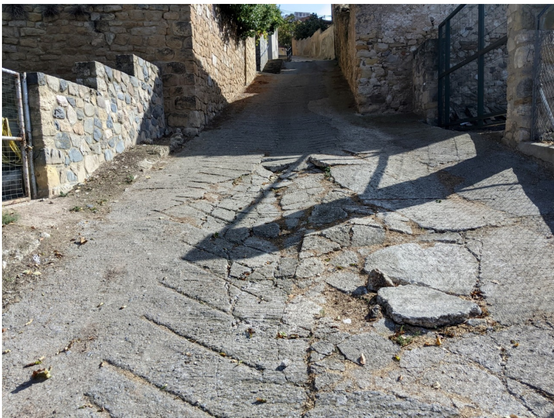
VISTA ZONA AMB TRENCAMENT
